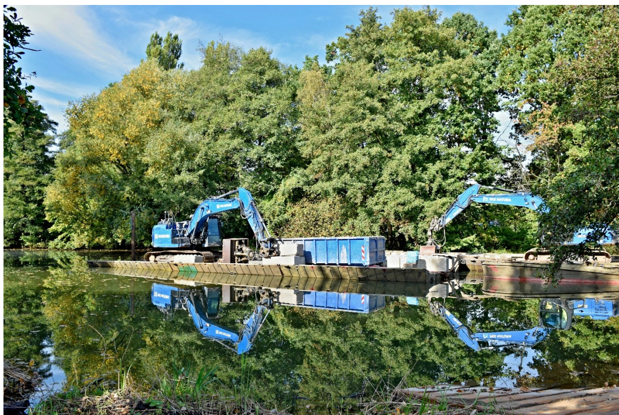
Díky pontonům mohou bagry pracovat přímo z hladiny (foto: Michal Vávra, Povodí Labe)
