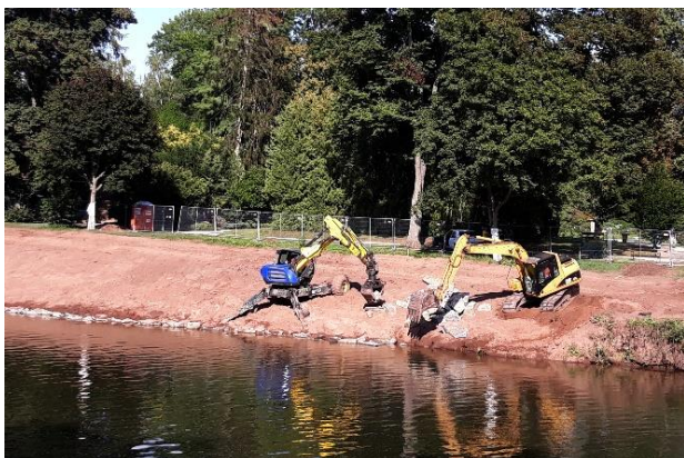
Opevňování břehu a závěrečné terénní úpravy
