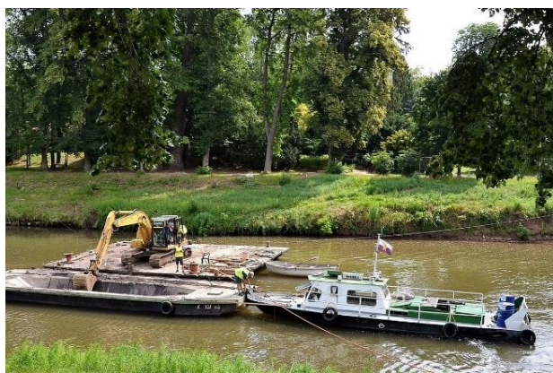
Těžba a odvoz nežádoucích nánosů ze dna řeky a ze břehu
