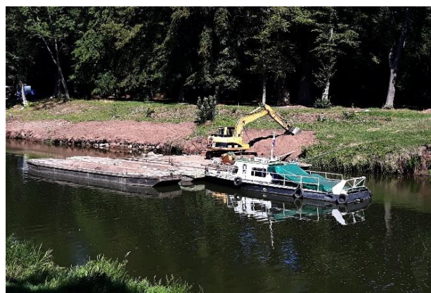
Těžba a odvoz nežádoucích nánosů ze dna řeky a ze břehu
