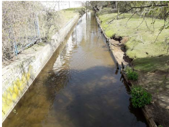
Poškozená protipovodňová hráz a břehové opevnění
