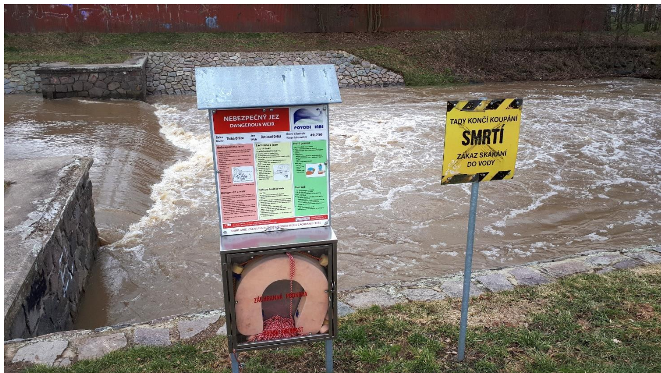
Záchranné prvky na jezu v Ústí nad Orlicí na Tiché Orlicí
