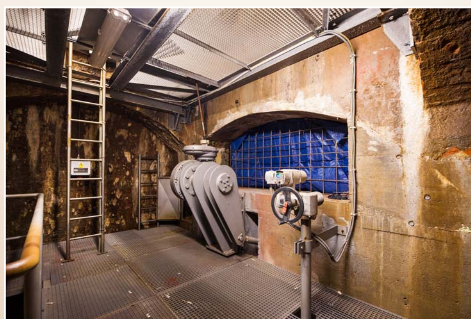
Strojovna uzávěrů pravé výpusti
