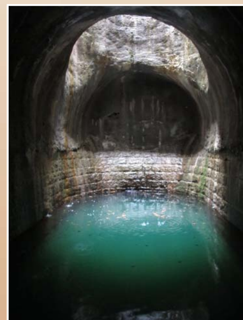
Vývar levého šachtového přelivu
