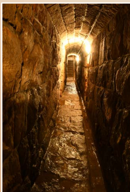
Revizní chodba v hrázi
