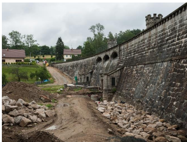
VD Fojtka, stavba nouzového přelivu
