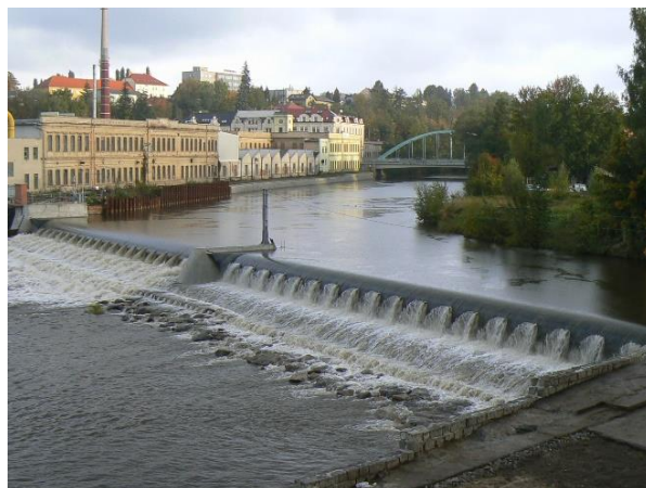
Jez v Turnově po rekonstrukci
