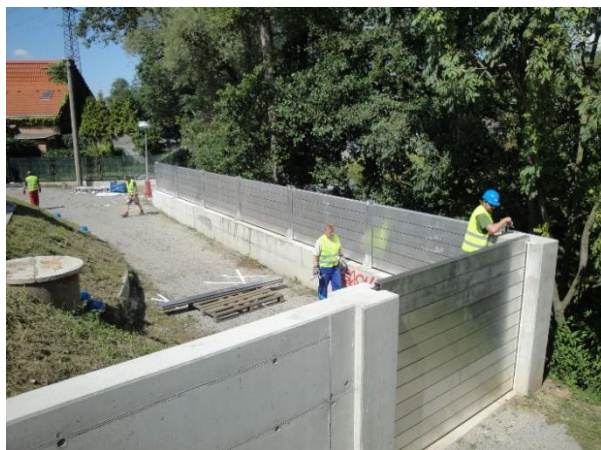
Výstavba PPO Benátky nad Jizerou
