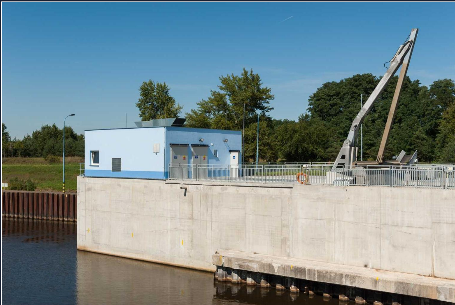
Malá vodní elektrárna byla vybudována mezi jezem a plavební komorou v letech 1994-95. V roce 2019 byla dokončena její celková rekonstrukce.
