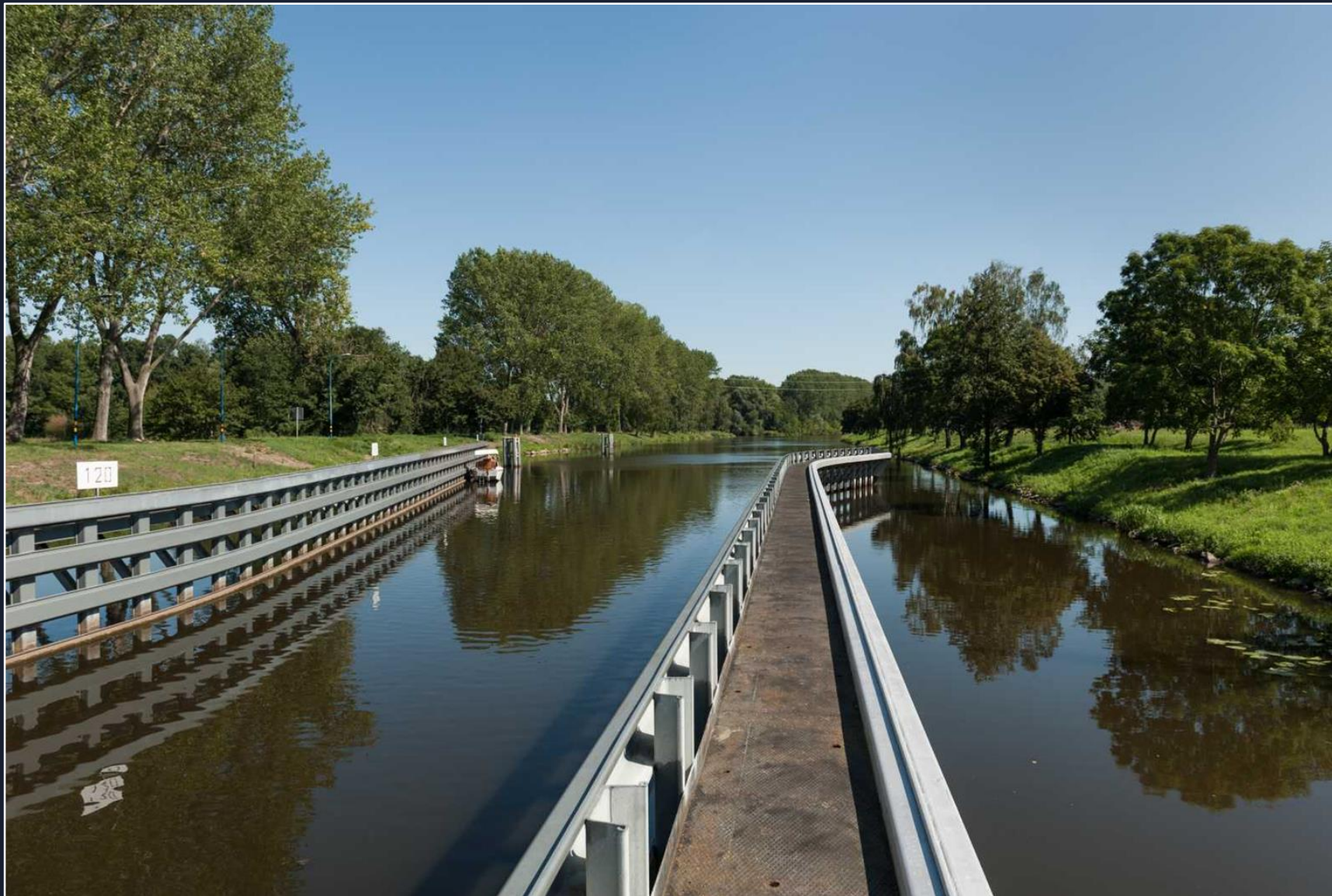
Na plavební komoru navazuje horní plavební kanál.
