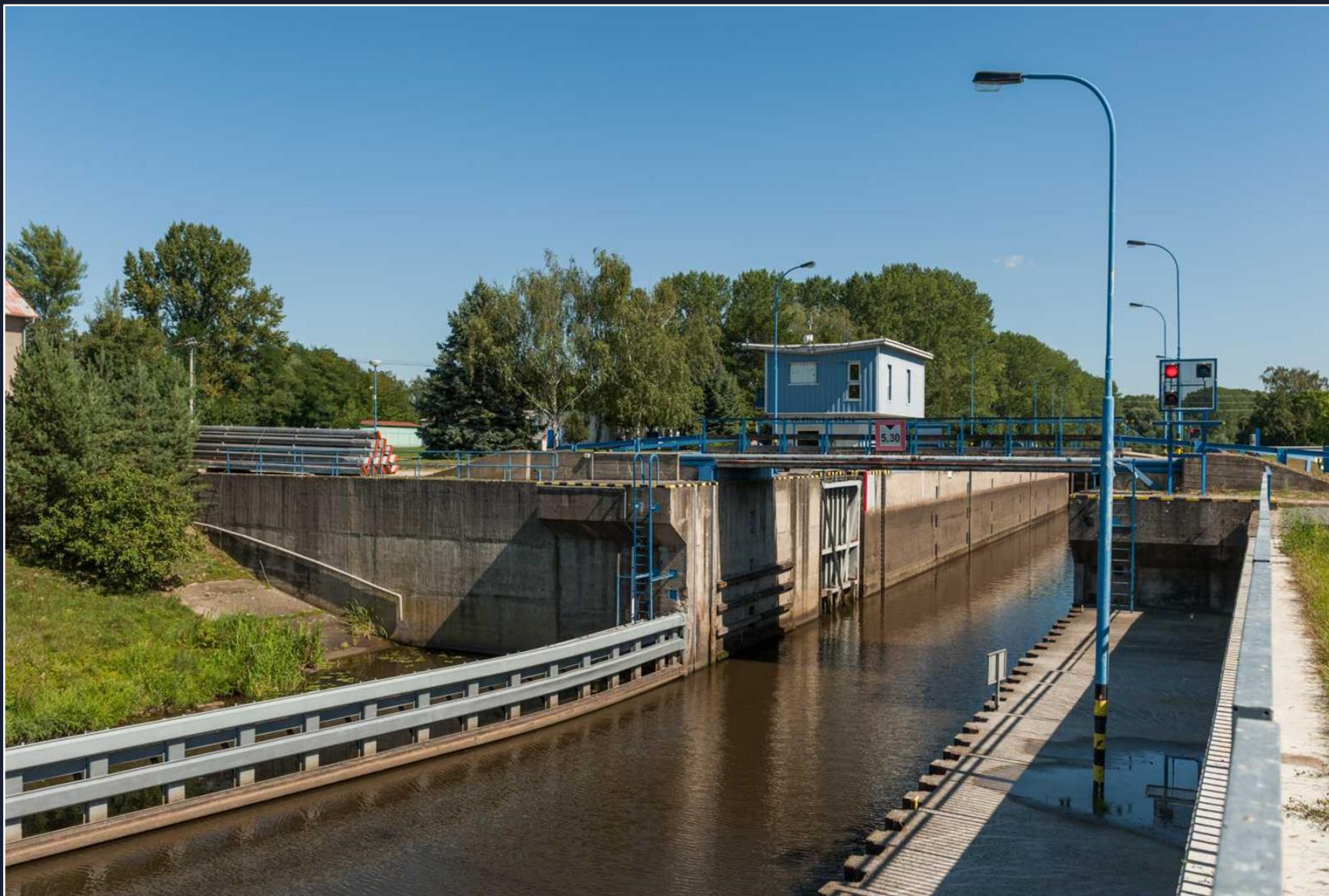
Plavební komora je umístěna při pravém břehu Labe.
