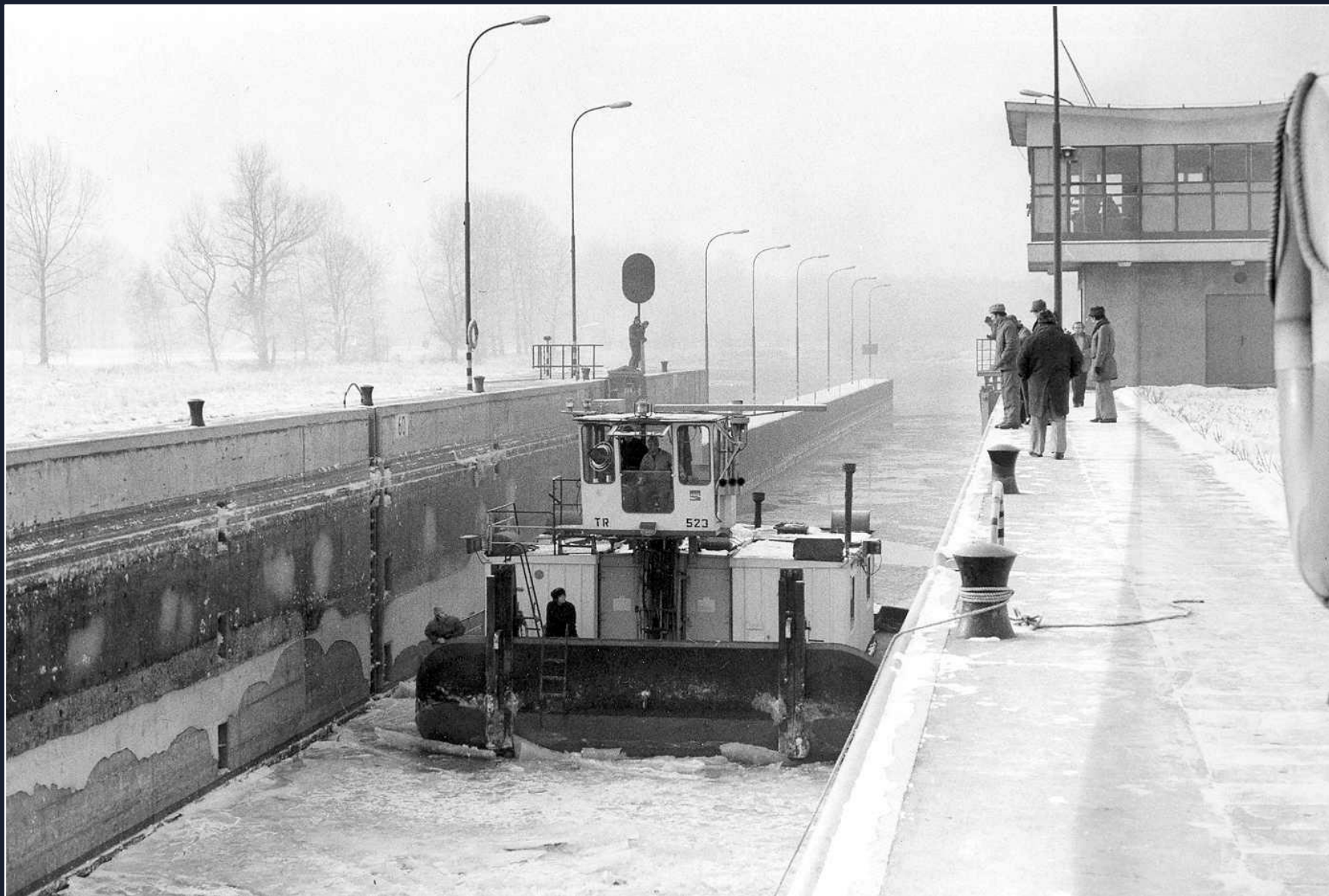
Bourání ledu v plavební komoře v lednu 1979
