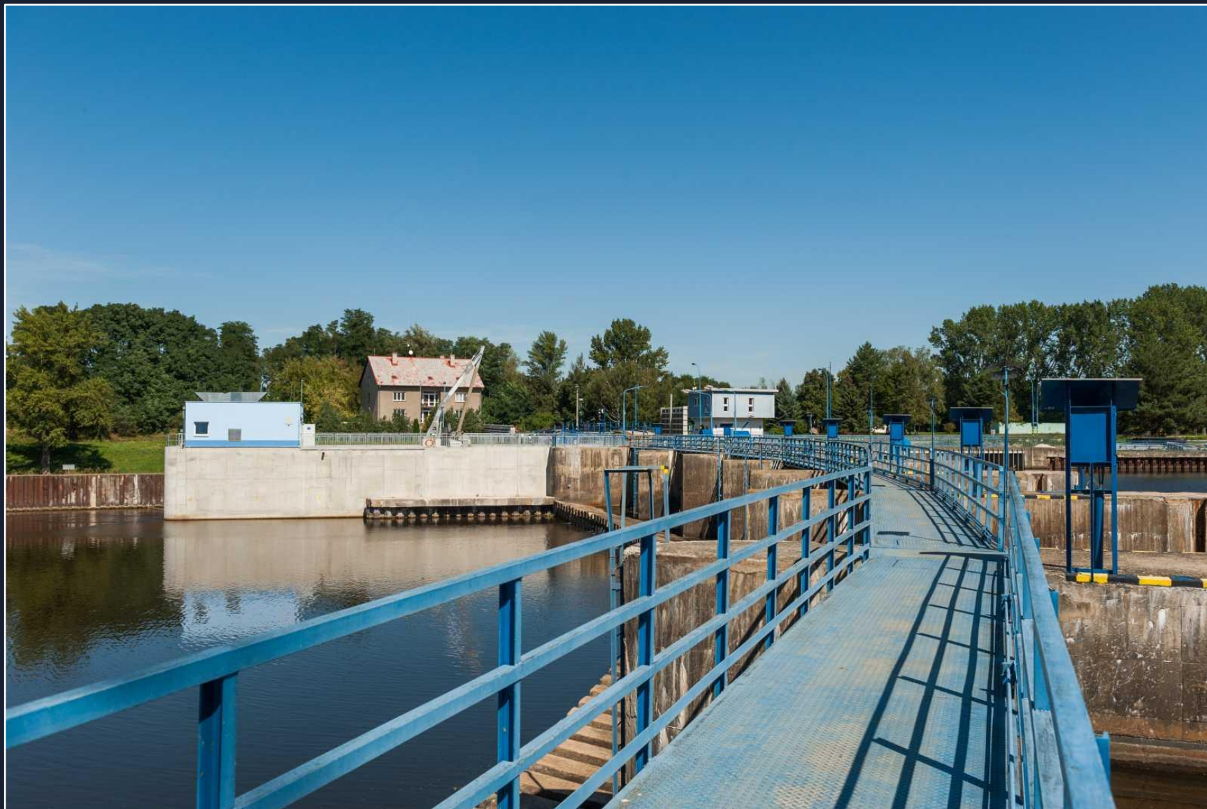
Dělicí pilíře jezu jsou spojeny obslužnou lávkou.
