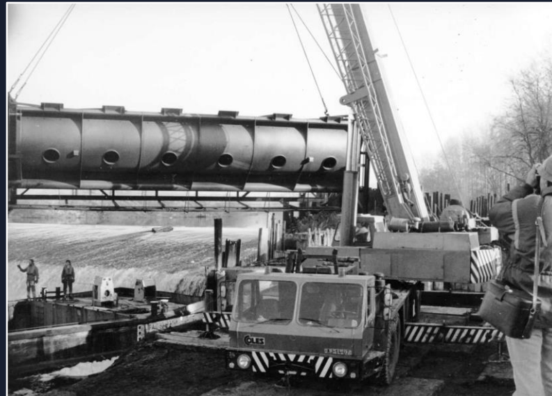
Doprava a osazování dutých klapek při přestavbě v letech 1985-91
