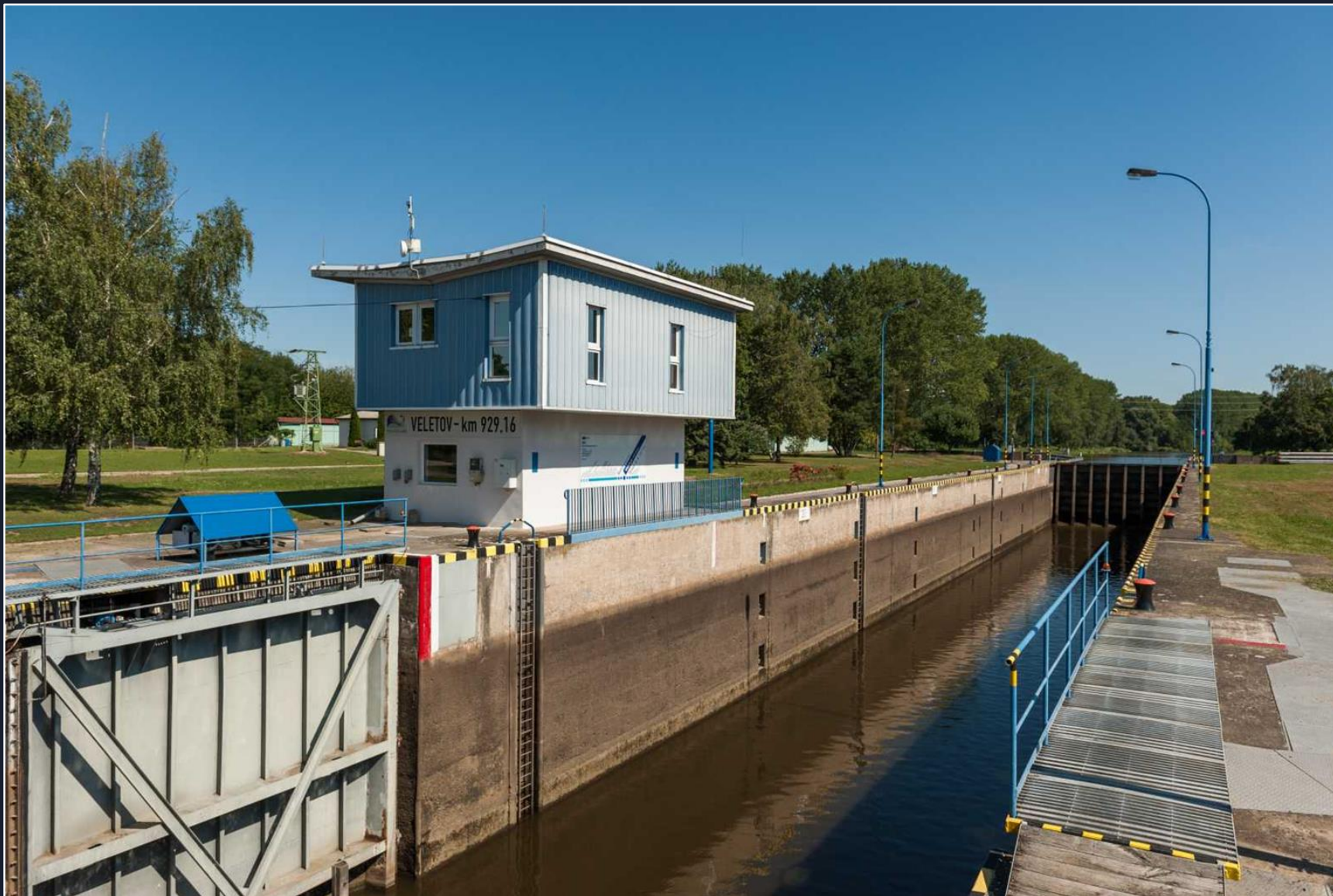
Užitné rozměry plavební komory jsou 85 x 12 x 3,5 m.
