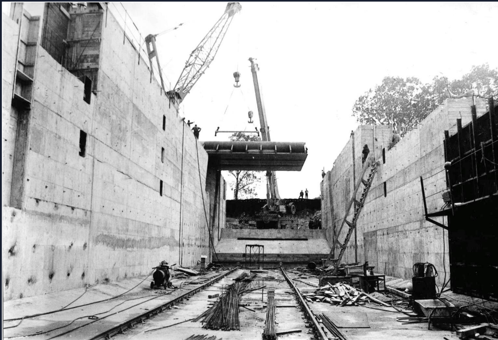
Výstavba plavební komory (1974)
