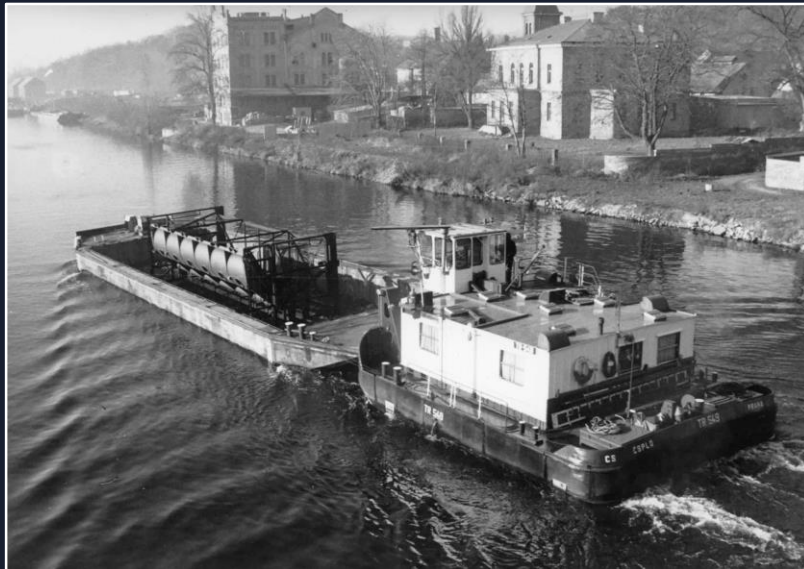
Doprava a osazování dutých klapek při přestavbě v letech 1985-91
