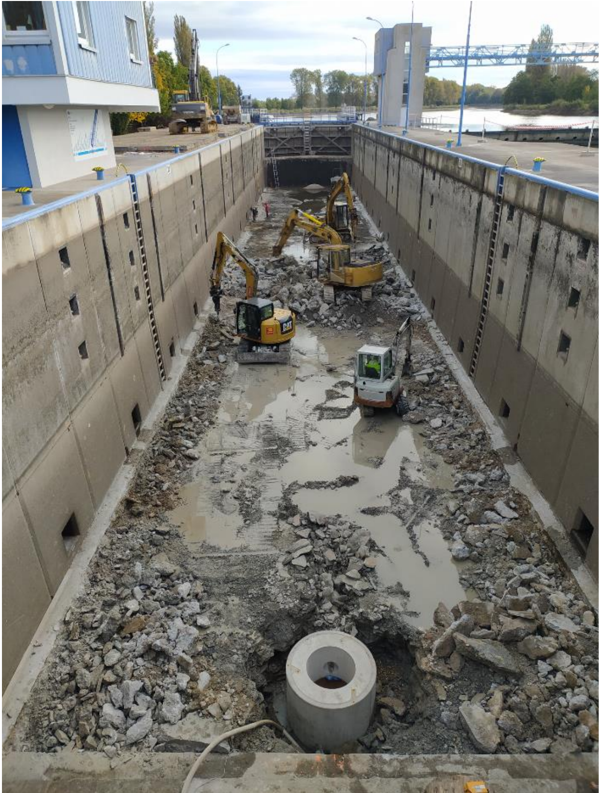
Bourací práce původního dna
