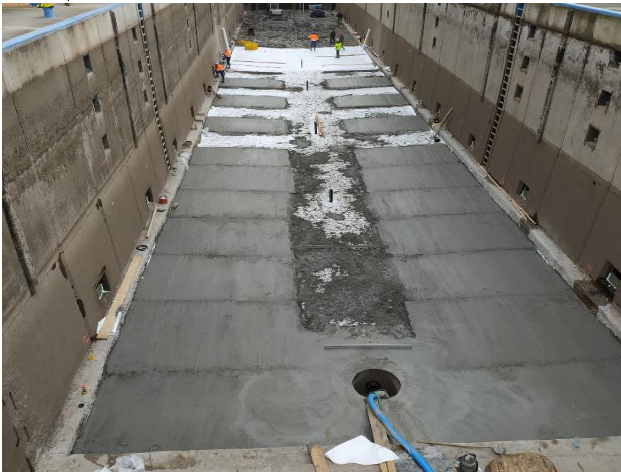
Betonáže podkladních betonů
