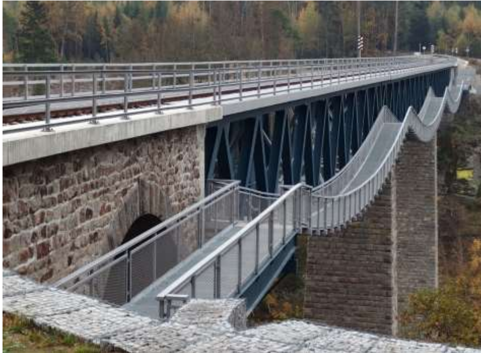
Obr. 3 Rekonstruovaný železniční most s lávkou pro pěší
