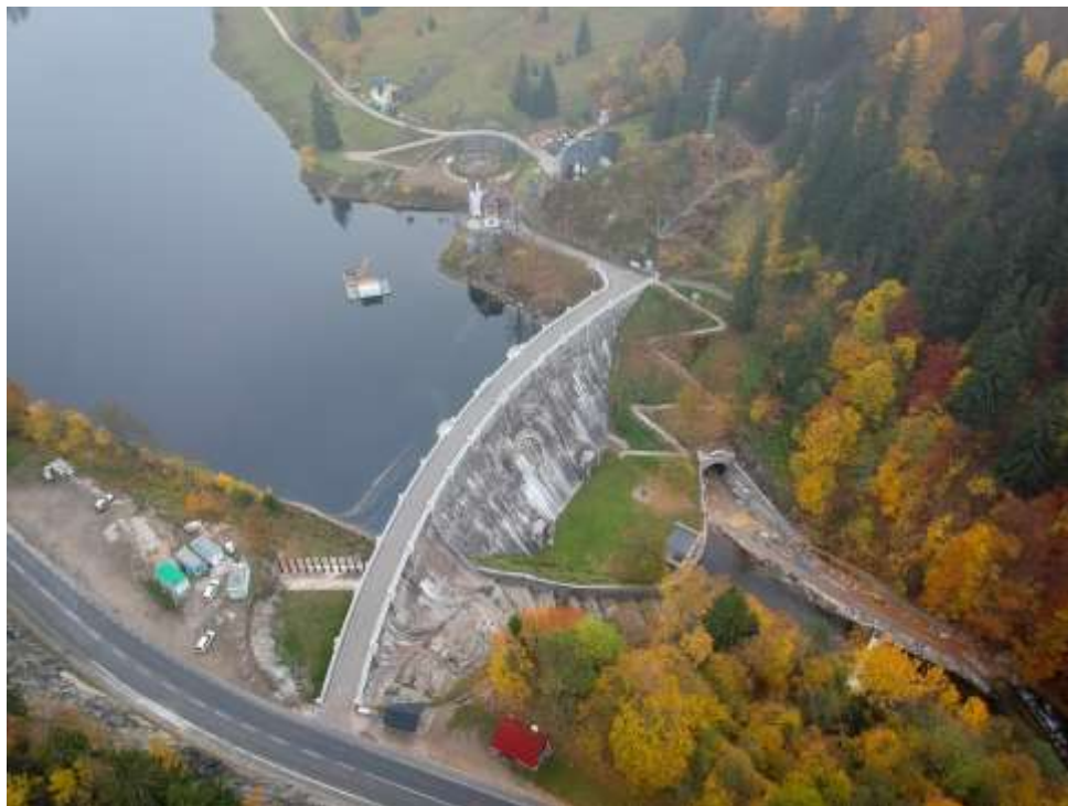
Obr. 1 Celkový pohled na vodní dílo Labská
