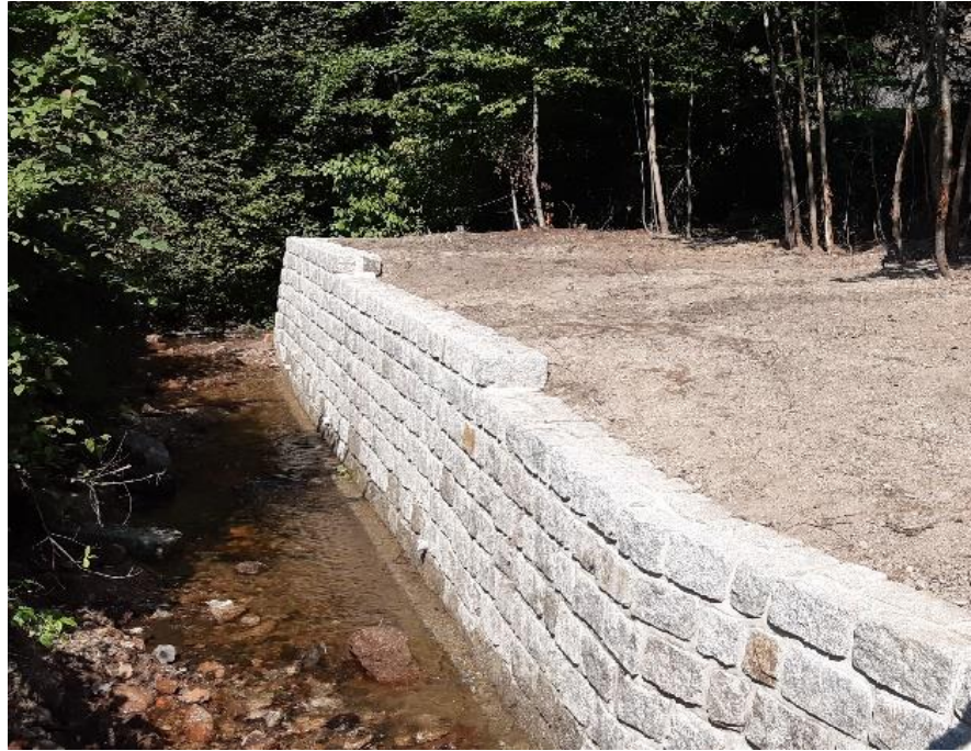
Úsek č. 3 v průběhu opravy a po dokončení
