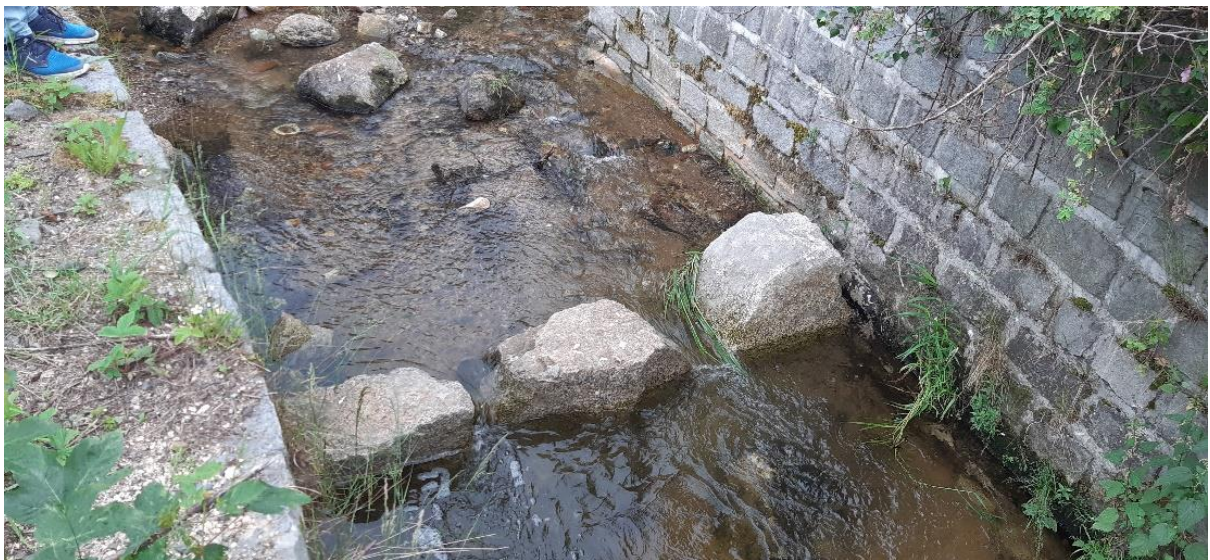
Obnovený příčný práh – úsek č. 6
