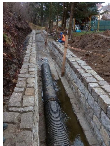
Úsek č. 14 před dokončením
