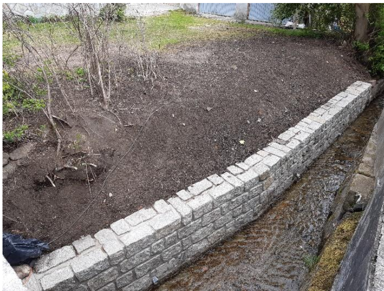
Úsek č. 10 – zúžený profil
