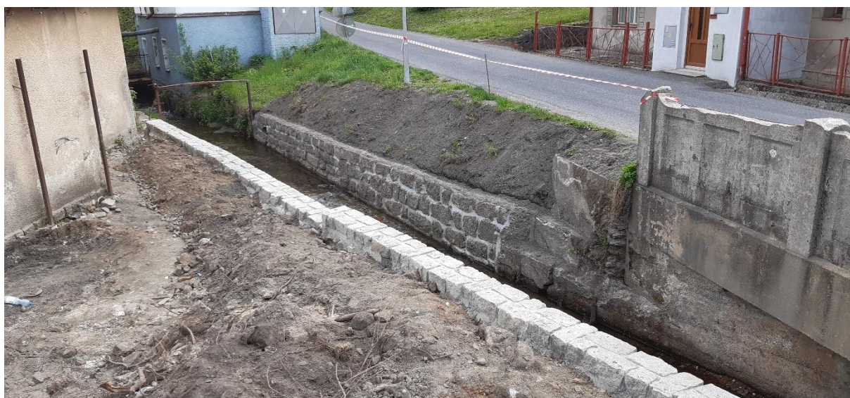
Úsek č. 10 – stará a nová zeď
