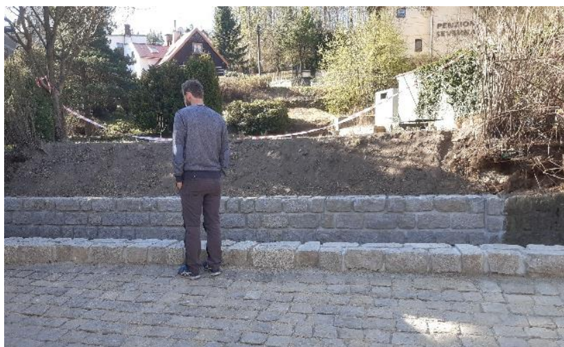
Úsek č. 12 - změna PD na pravém břehu
