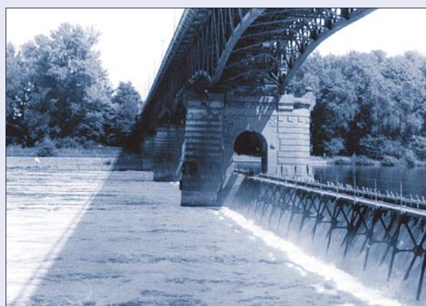
Obr. 43 Hradlový jez v Roudnici nad Labem, 1912
