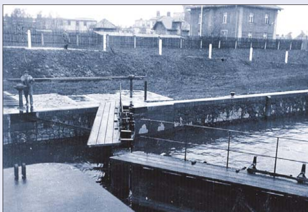
Obr. 44 Dolní zpěrná vrata plavební komory v Lovosicích, 1920
