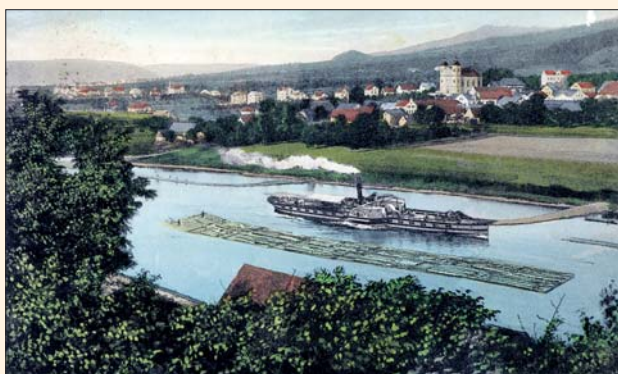
Obr. 32 Plavební provoz v Nebočadech, konec 19. století
