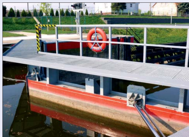
Obr. 83 České Kopisty, dolní vzpěrná vrata malé plavební komory
