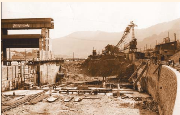
Obr. 61 Stavební jáma v místě vodní elektrárny, 1933
