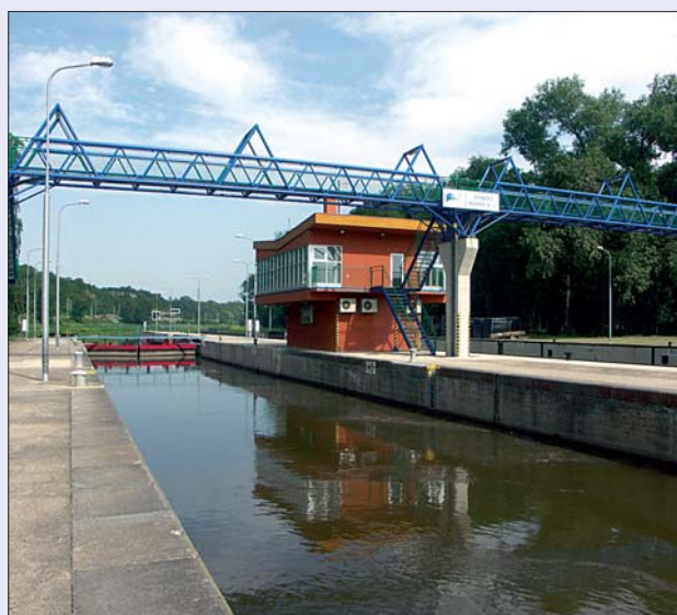
Obr. 80 Roudnice nad Labem, velká plavební komora
