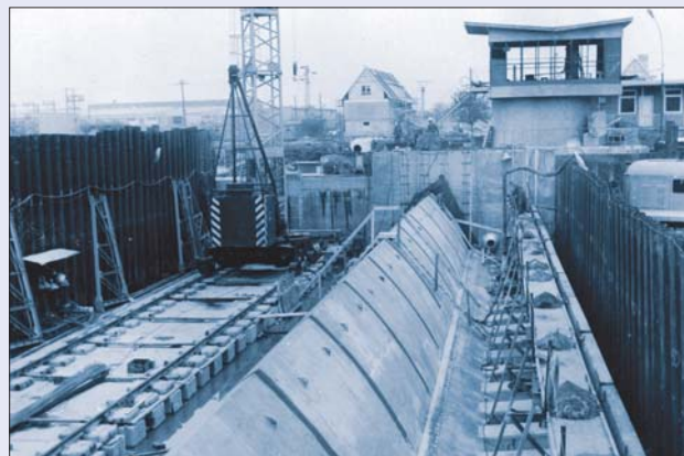
Obr. 76 Dolní Beřkovice, výstavba hydrostatického sektorového jezu, 1972
