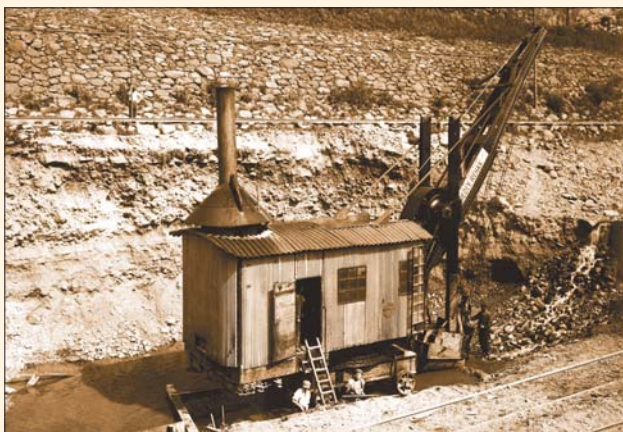
Obr. 58 Zemní práce prováděné parním bagrem, 1924
