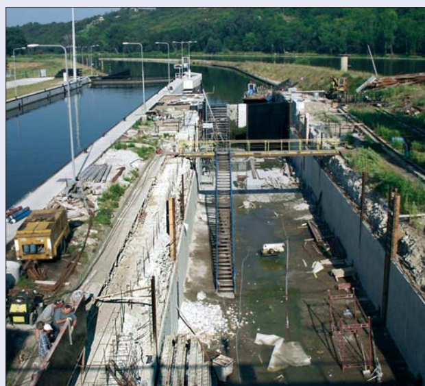
Obr. 77 Štětí, rekonstrukce malé plavební komory, 2004
