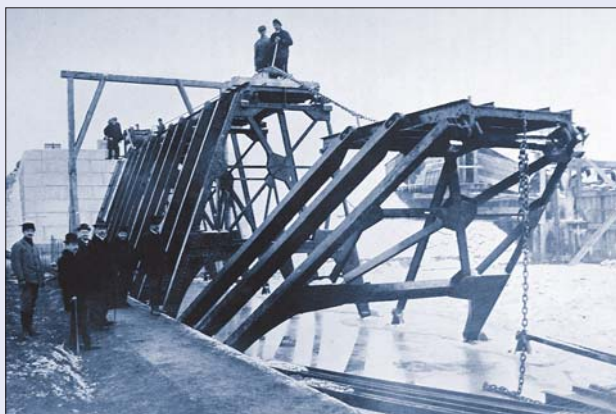
Obr. 45 Zkušební sklápění slupic v Českých Kopistech, kolem roku 1912
