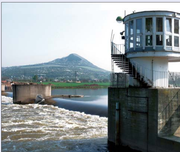
Obr. 80 Lovosice, hydraulický sektorový jez
