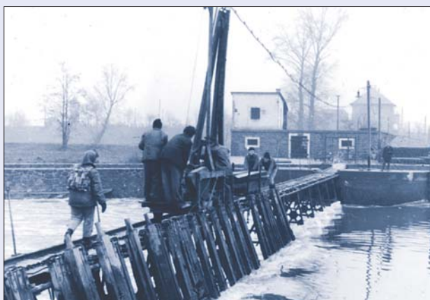
Obr. 48 Poslední vyhrazování hradlového jezu v Lovosicích, prosinec 1968
