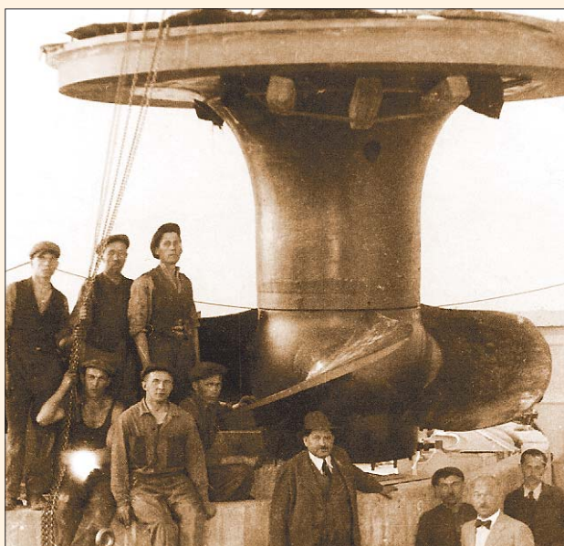
Obr. 63 Kaplanova turbína před instalací do vodní elektrárny Střekov, 1935
