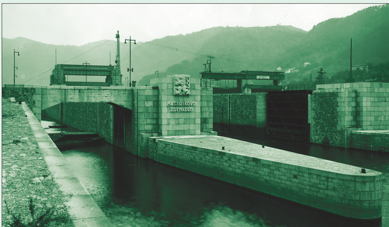
Obr. 74 Střekov, architektonické řešení dolního ohlaví plavebních komor, 1931
