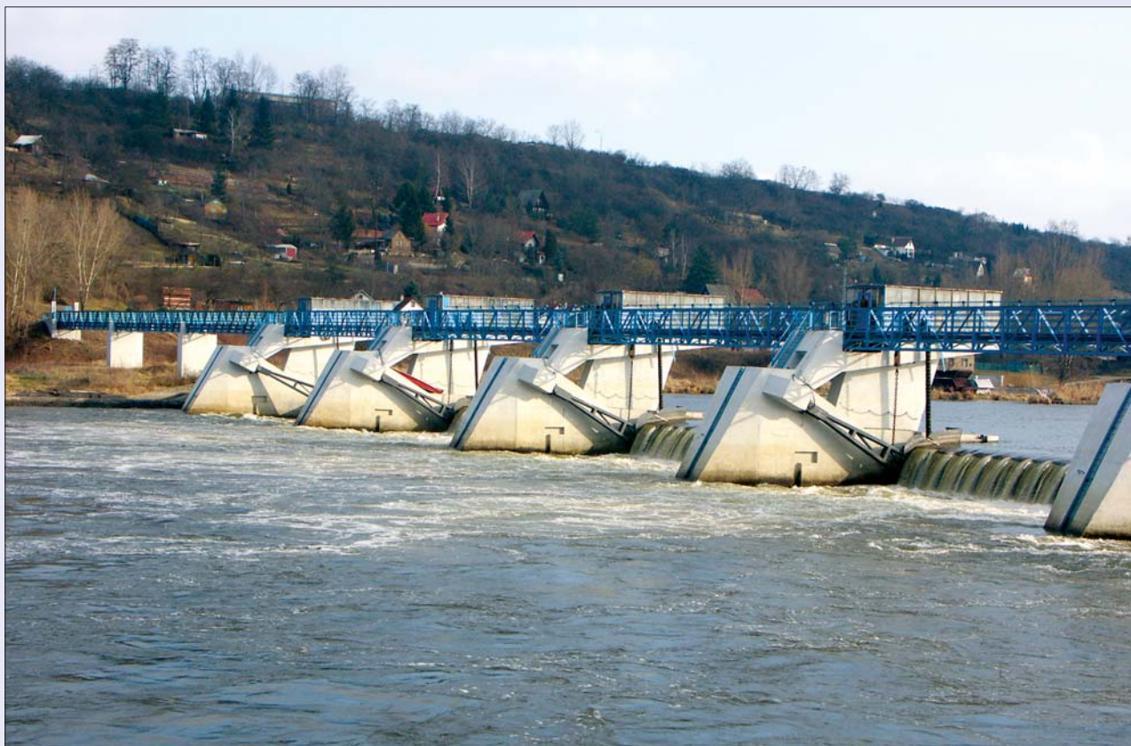
Obr. 78 Štětí, segmentový jez
