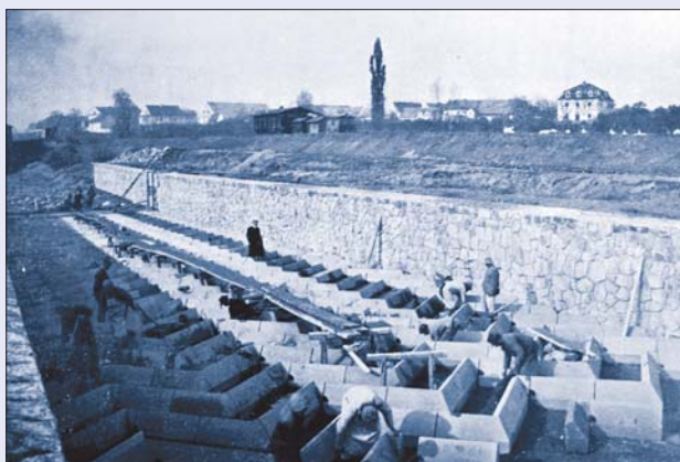
Obr. 47 Montáž rozražečů ve vorové propusti v Lovosicích, 1913
