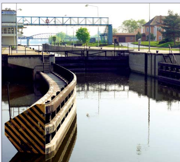
Obr. 79 Lovosice, malá plavební komora
