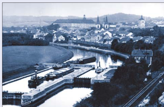
Obr. 42 Plavební komory v Roudnici nad Labem, 1912
