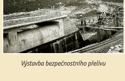
Výstavba bezpečnostního přelivu
