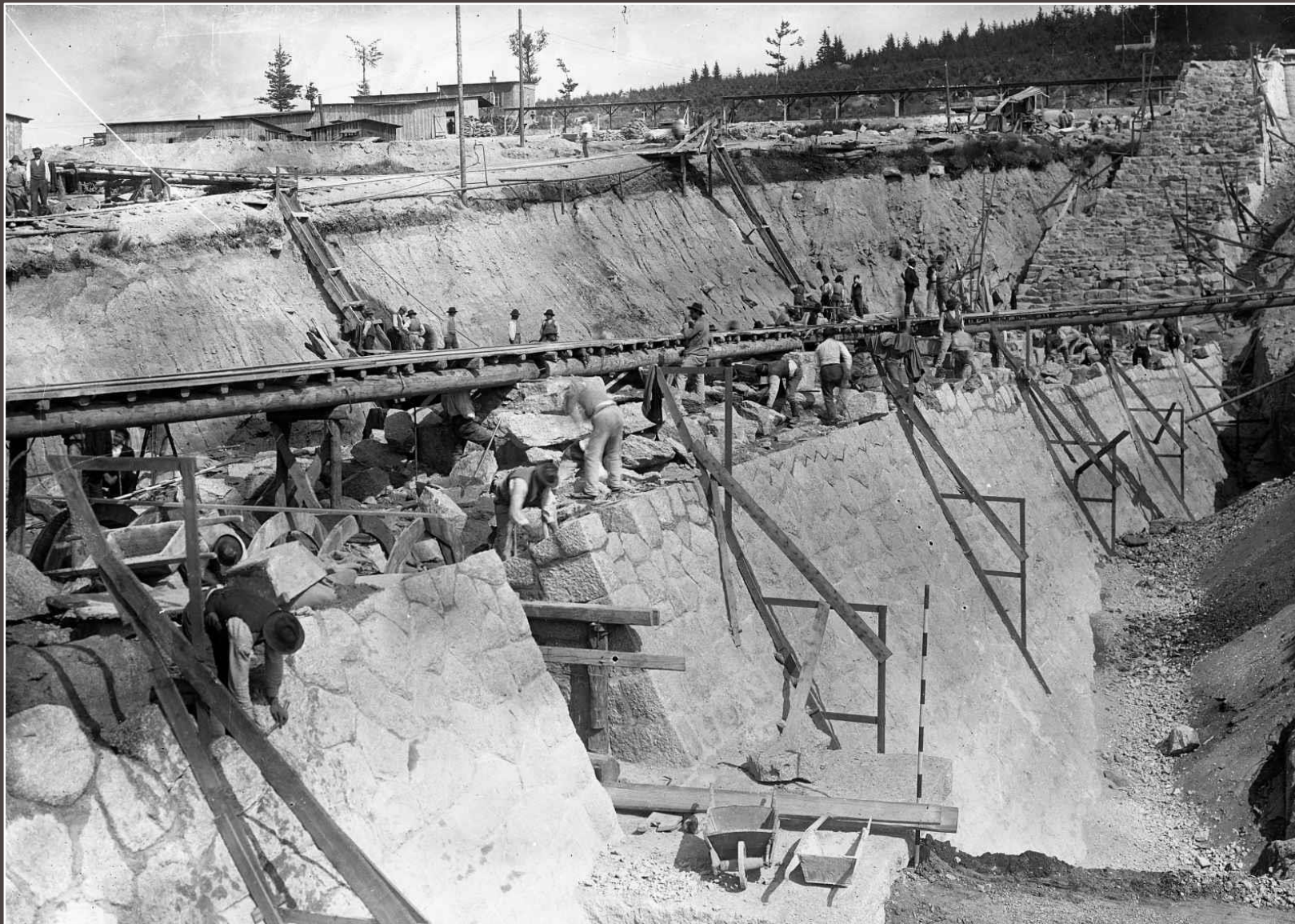
V roce 1904 probíhalo zdění hráze od základové spáry, která se nacházela až 8 m pod terénem.
