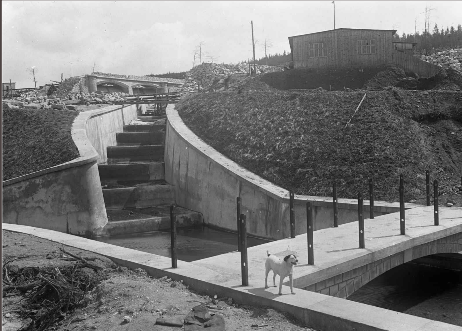
Korunový bezpečnostní přeliv budoucí přehrady spolu s kaskádou byl vybudován dříve než zbytek hráze.
