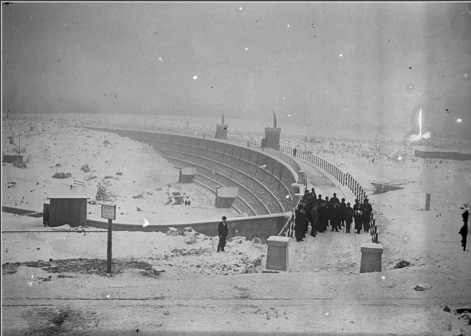
Stavba byla dokončena 21. prosince 1905.
