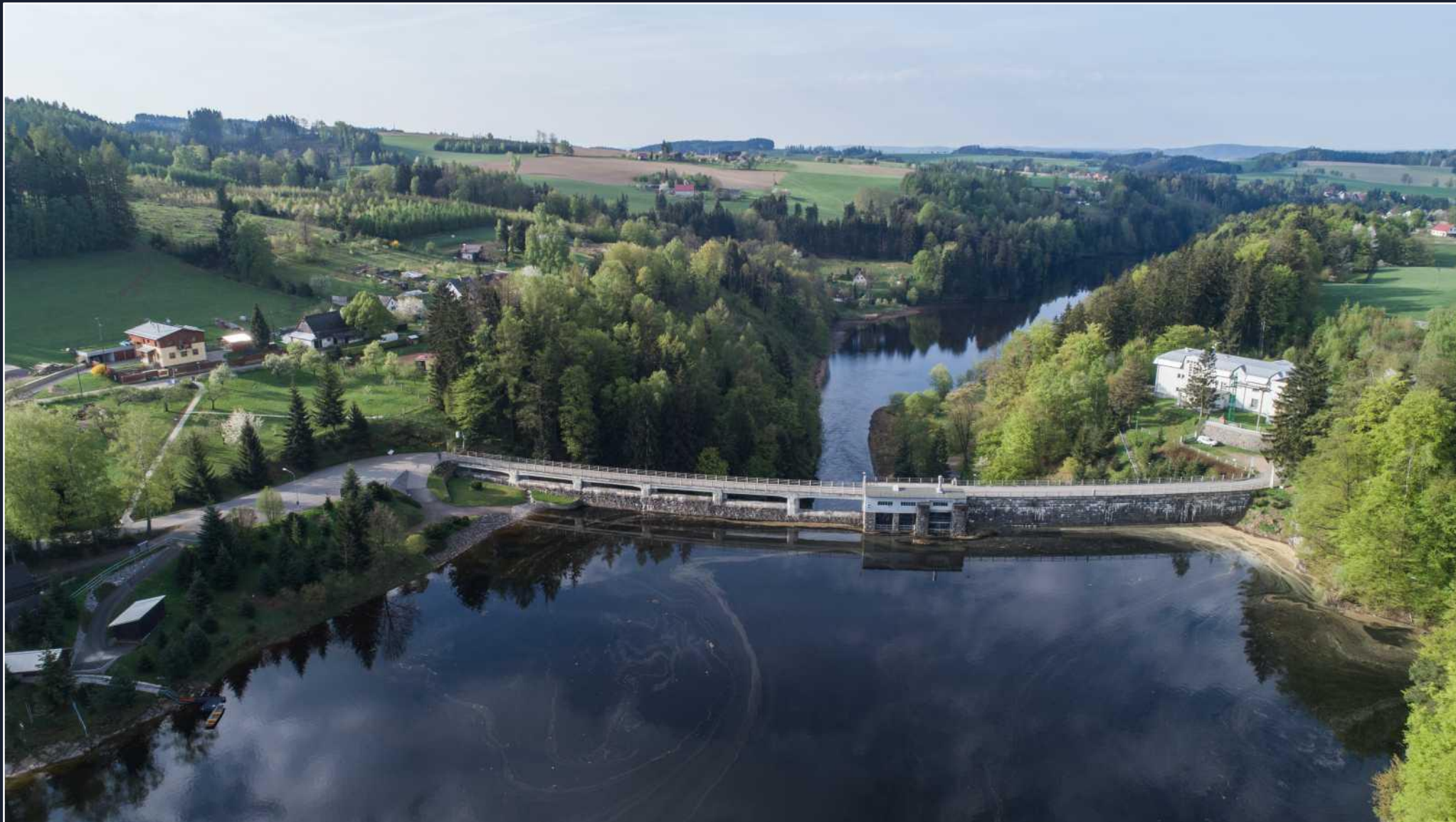
Hráz přehrady je gravitační, oblouková, zděná z lomového kamene.
