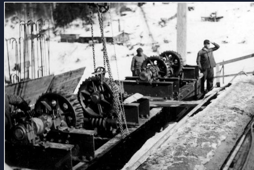
Ve strojovně je umístěno ovládání návodních uzávěrů a rychlouzávěru přivaděče na vodní elektrárnu. Na černobílém snímku je zachycena montáž zařízení v roce 1938.
