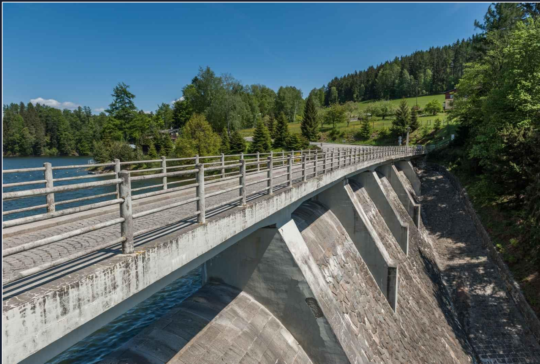
U levého břehu je bezpečnostní korunový přeliv o 6 nehrazených polích šířky 13 m s přelivnými hranami ve třech úrovních.
