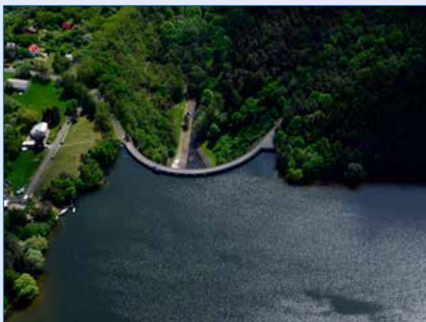
Vrchlice, přehrada Vrchlice – jediná klenbová přehradní hráz v České republice
