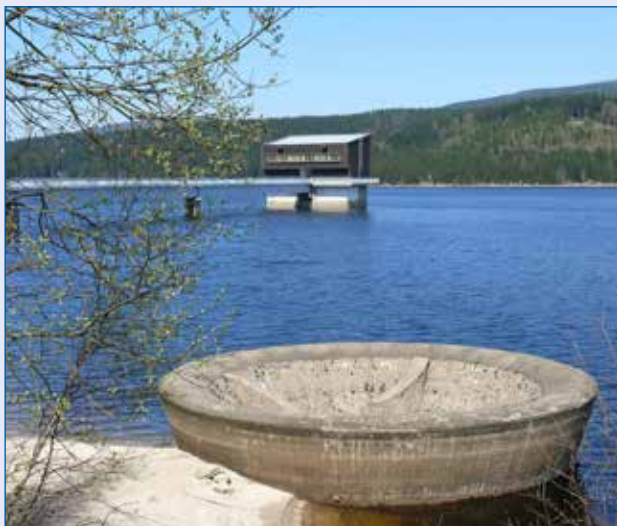
Kamenice, vodárenská nádrž Josefův Důl
