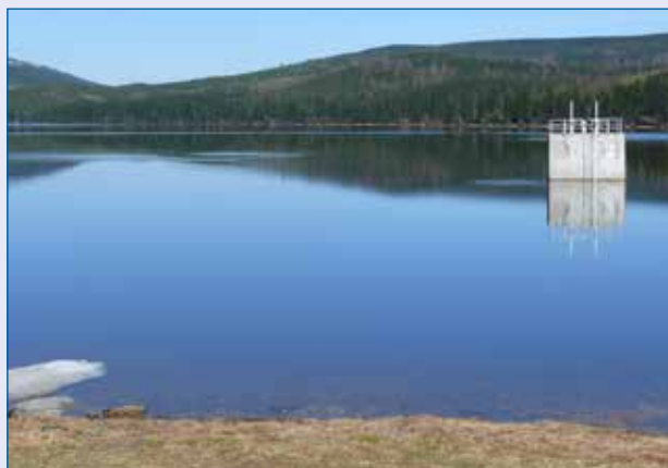
Černá Desná, vodárenská nádrž Souš – odběrný objekt
