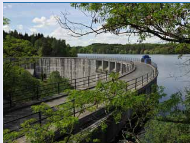
Vrchlice, vodárenská nádrž Vrchlice
