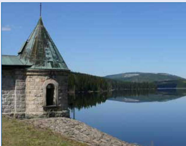
Černá Desná, vodárenská nádrž Souš
