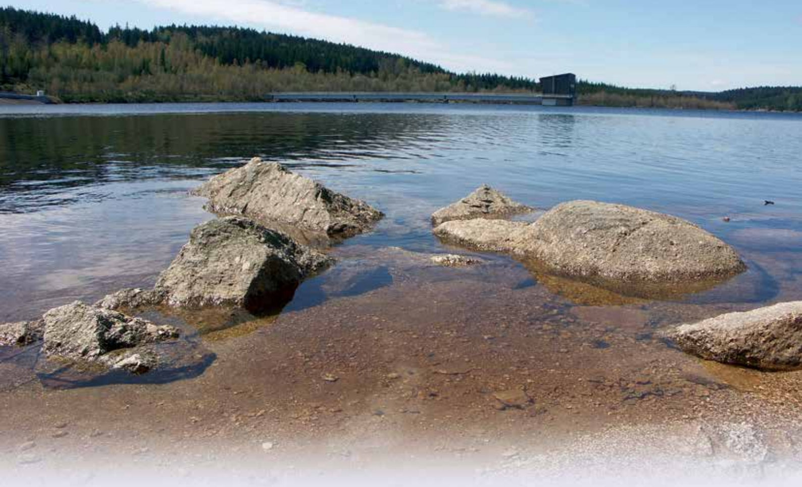
Kamenice, vodárenská nádrž Josefův Důl
