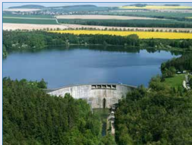
Vrchlice, vodárenská nádrž Vrchlice – nehlubší část nádrže před hrází
