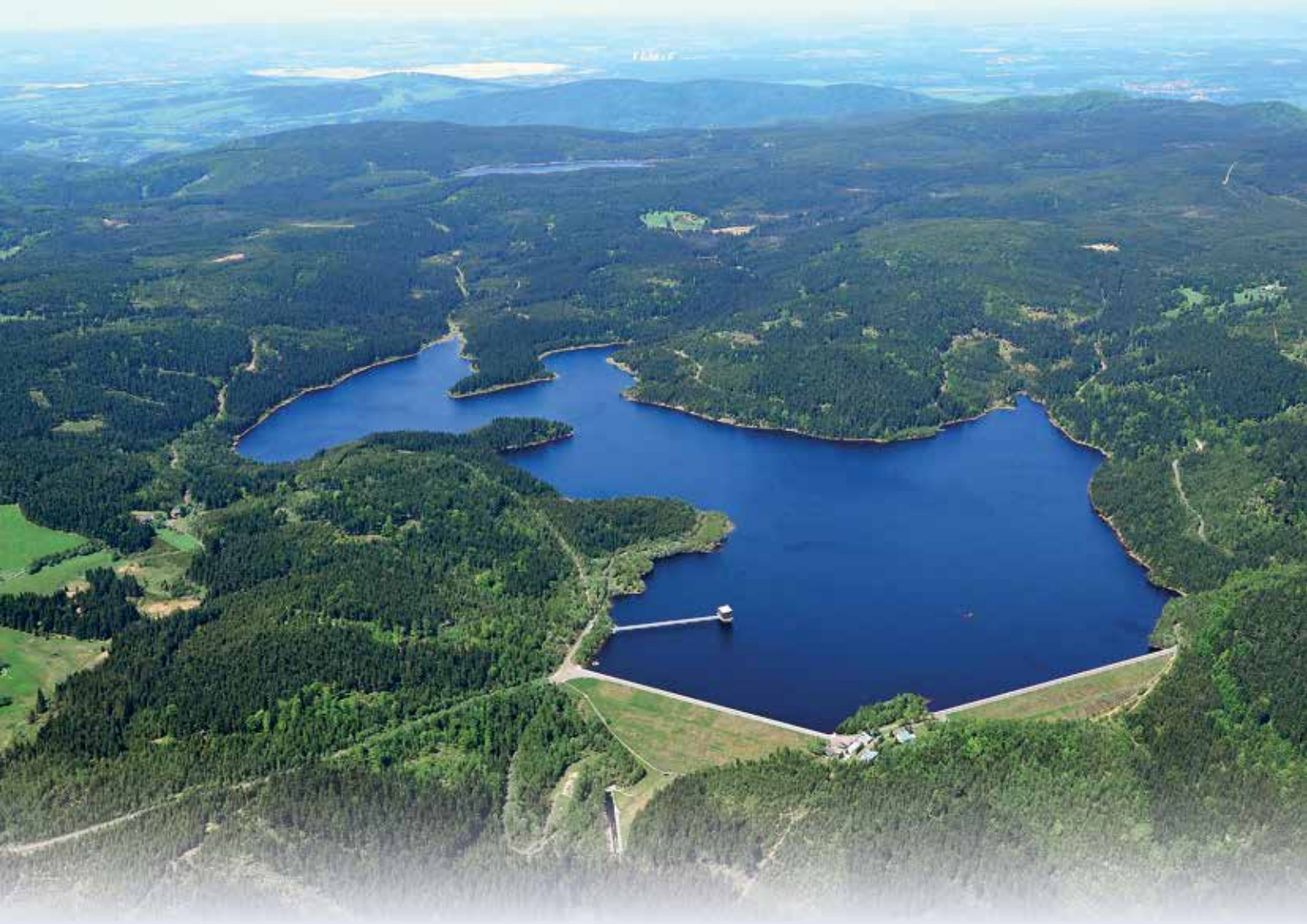
Kamenice, vodárenská nádrž Josefův Důl
