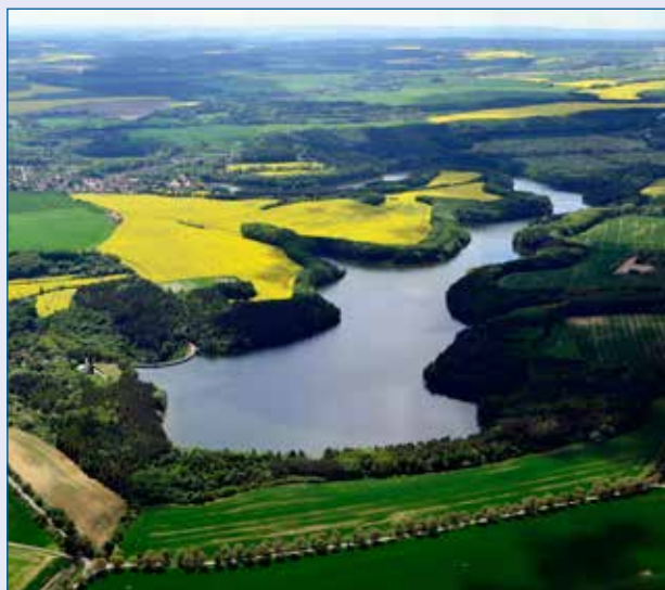
Vrchlice, vodárenská nádrž Vrchlice
