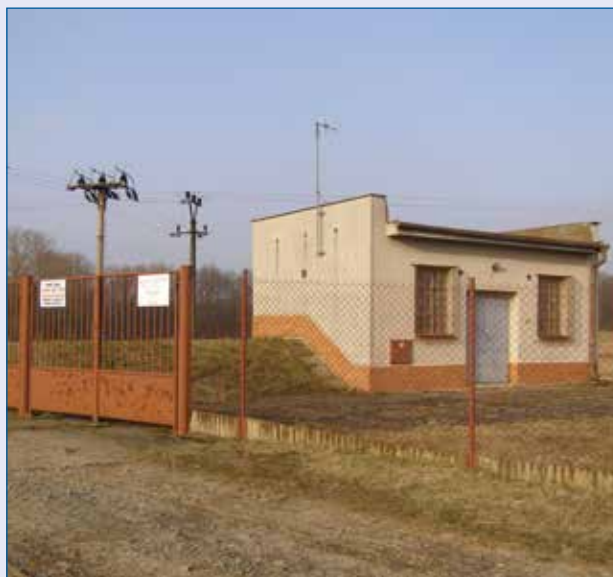
Litá, zdroj podzemní vody nad Českým Meziříčím
