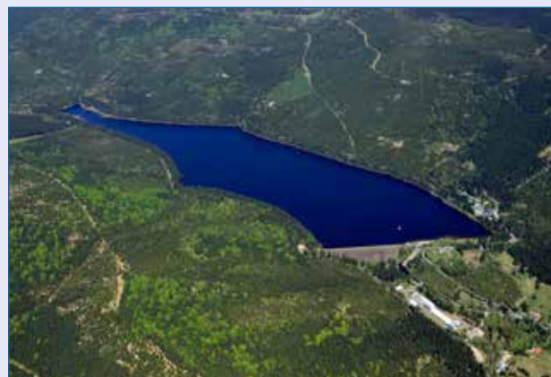
Černá Desná, vodárenská nádrž Souš
