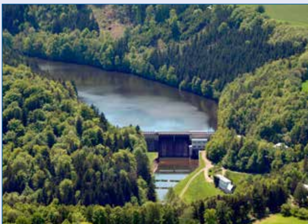
Chrudimka, vodárenská nádrž Křižanovice – nejhlubší část nádrže před hrází
