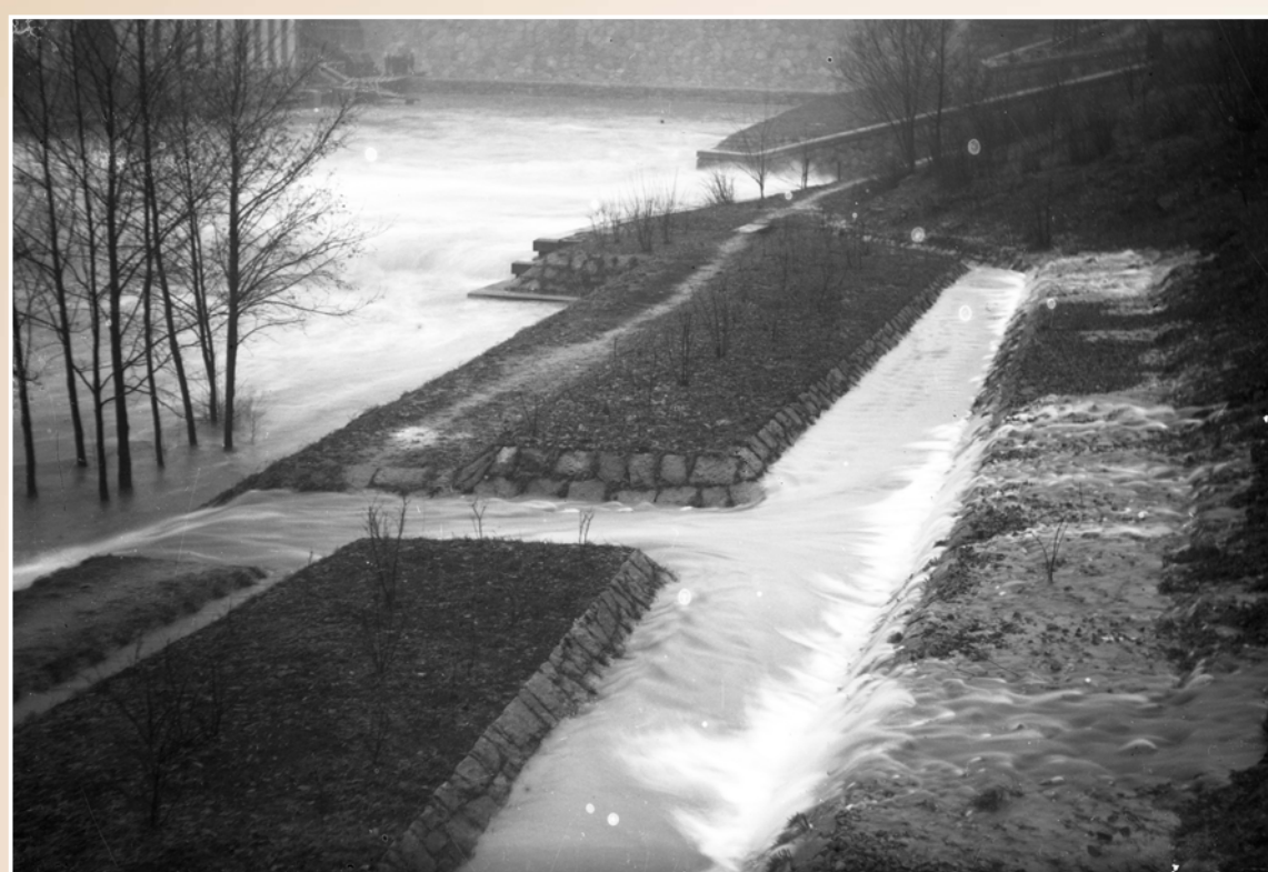
Průsaky na levém úbočí pod hrázi při povodni v únoru 1923
