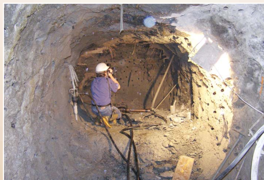
Bourání otvoru v betonové zátce
