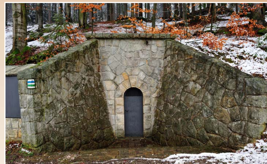
Vstup do kontrolní chodby z roku 1938
