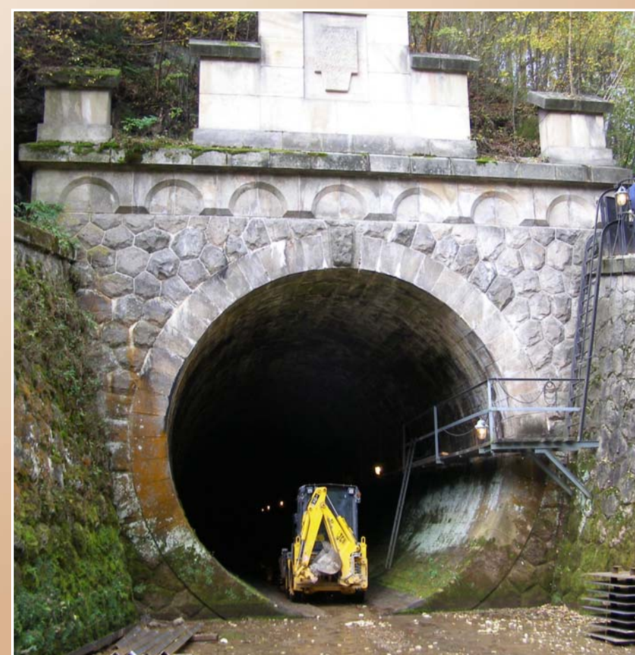
Výtokový portál pravého tunelu
