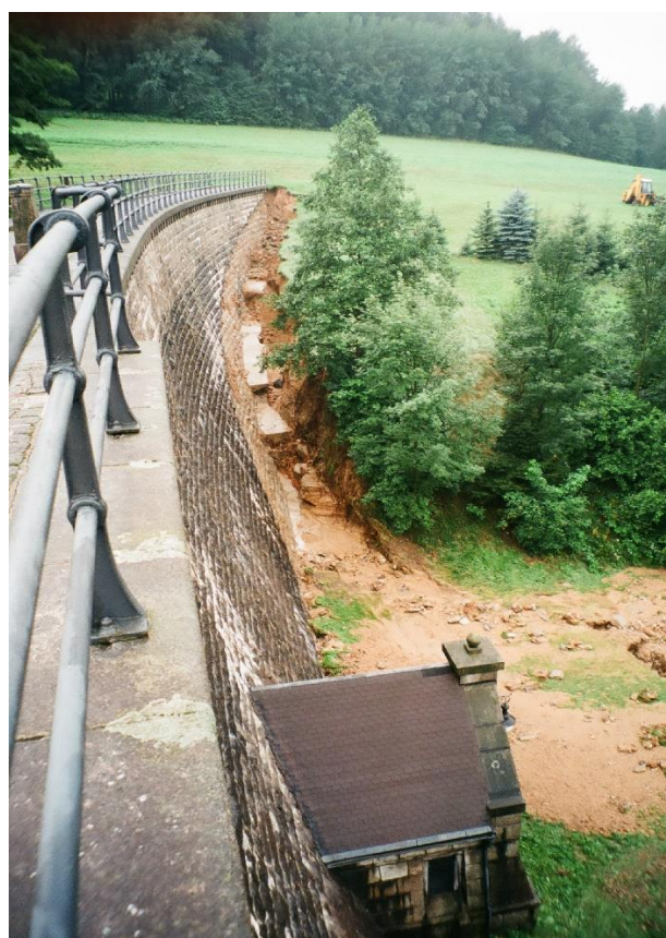
Přelití koruny hráze na 4 km vzdáleném vodním díle Mlýnice dne 7.8.2010 a následné škody
