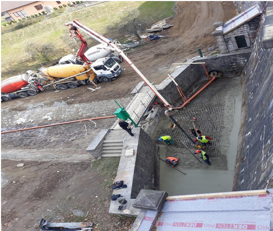
SO 03 - Betonáž dna vývaru pod bezpečnostním přelivem
