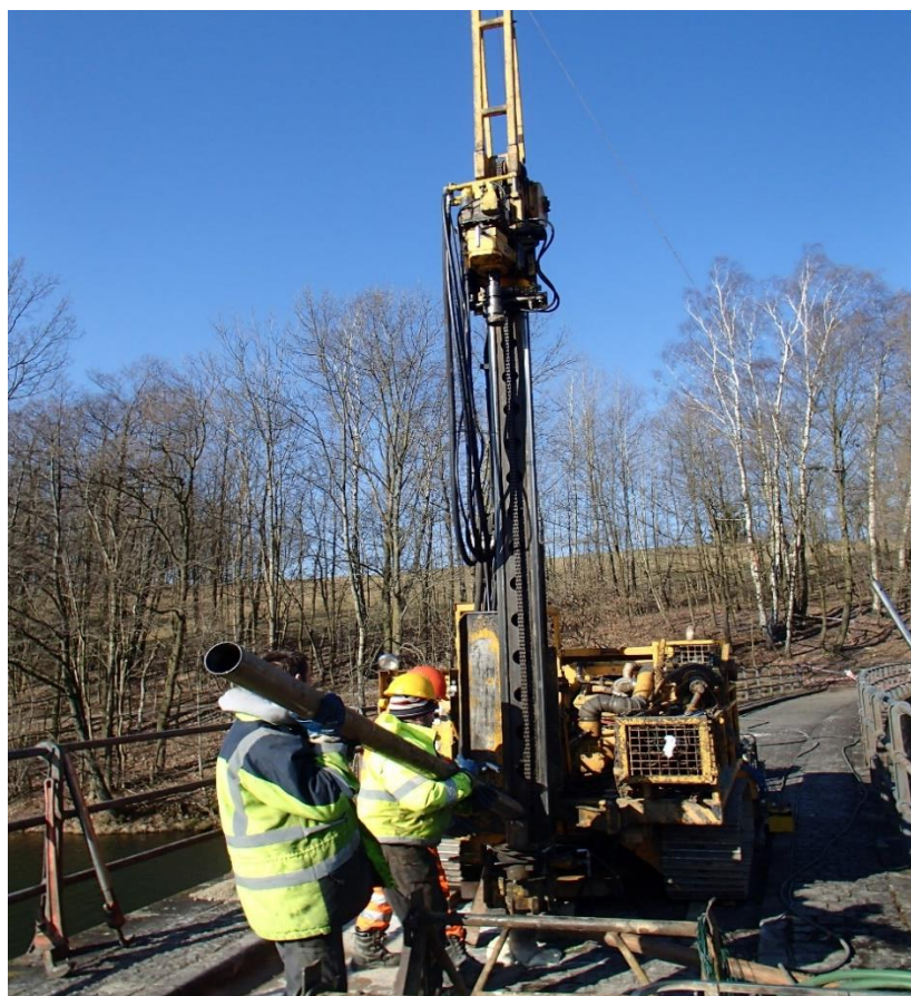
SO 04 – Realizace vstrojeného vrtu V3 na hrázi
