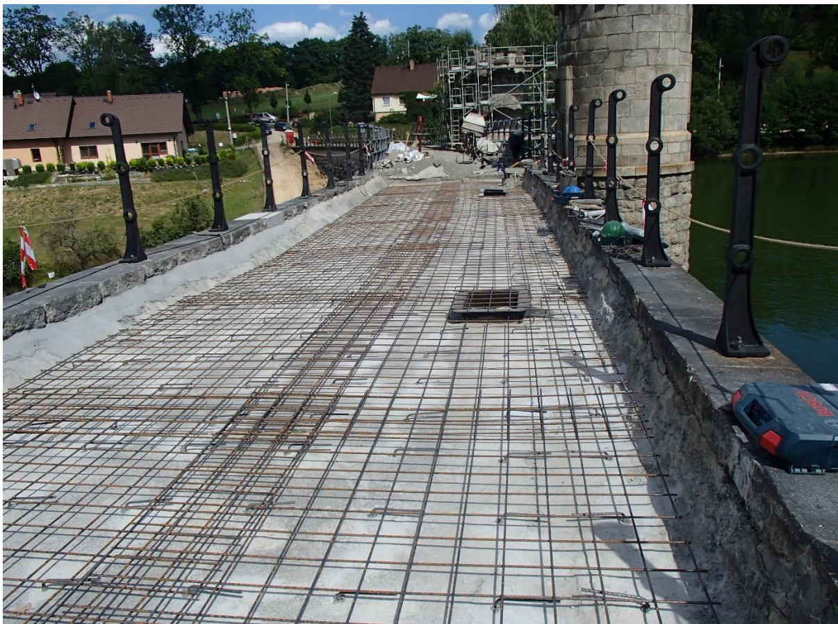
SO 01 - Přípravenost výztuže koruny hráze před betonáží
