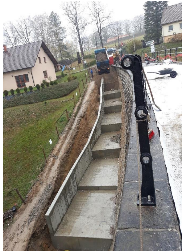
SO 03 – Výstavba a dokončení pravé podzemní kaskády
