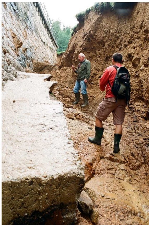
Přelití koruny hráze na 4 km vzdáleném vodním díle Mlýnice dne 7.8.2010 a následné škody
