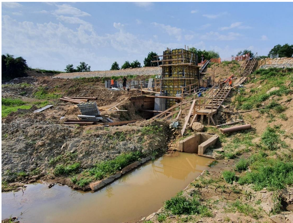
Hráz MVN s nově budovaným výpustným zařízením, v popředí staré výpustné zařízení
