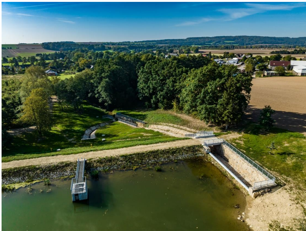
Hráz, výpustné zařízení a bezpečnostní přeliv
