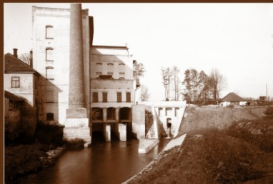
Mlýn Automat firmy Josef Voženilek s původní vodní elektrárnou, 1916
