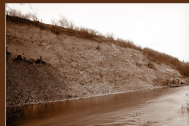
Těžba záhozového kamene v opukovém lomu u Skaličky, 1921
