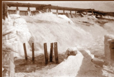
Pevný jez těsně před zřícením, leden 1918
