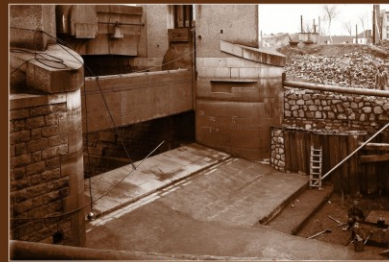
Zabezpečení levého jezového pole betonovou deskou, 1. 12. 1932
