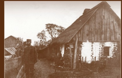
Domek stálého strážce u pevného jezu, 1916
