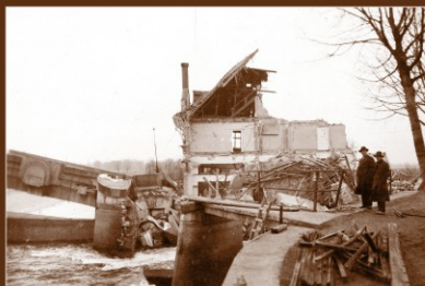
Vodní elektrárna, silniční most a vtokový objekt z horní vody, 11. 4. 1932
