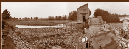
Sanace porušené části jezu a vodní elektrárny, 22. 7. 1932
