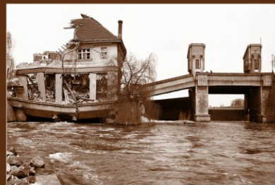
Zřícená vodní elektrárna a pravá část jezu, 11. 4. 1932
