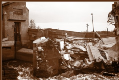
Pravobřežní jezový pilíř, 20. 4. 1932
