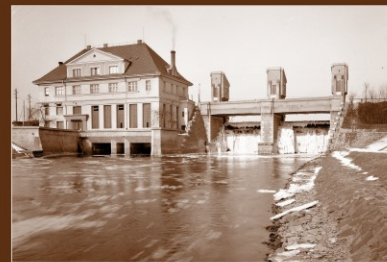
Pohled na jez s vodní elektrárnou a silničním mostem, únor 1924
