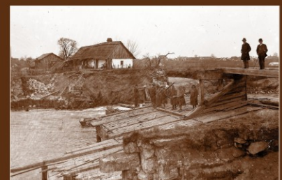
Zajišťovací práce na zříceném jezu, 5. 5. 1918
