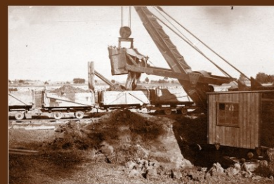
Nakládka výkopu parním „putnovým rýpadlem“, 1915
