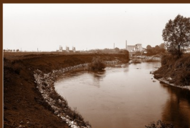
Upravené koryto Labe nad pohyblivým jezem Předměřice, 1918
