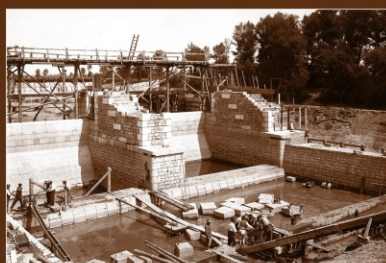
Staveniště spodní stavby jezu, 1914
