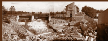
Hradlový jez v místě pravého jezového pole a vodní elektrárny, 1. 10. 1932
