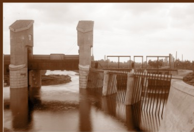
Česle před vtokem budoucí vodní elektrárny, 1918
