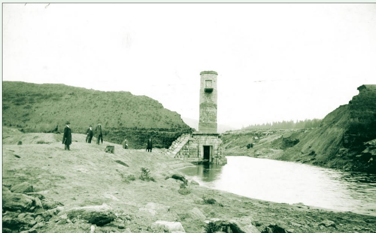
Obr. 40. Bílá Desná, přehrada po havárii, pohled ze vzdušné strany, 21. 9. 1916
