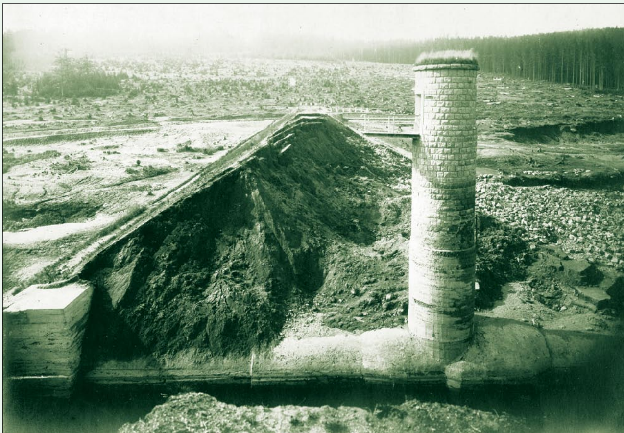
Obr. 35. Bílá Desná, přehradní těleso a výpustná štola v místě protržení, 1916
