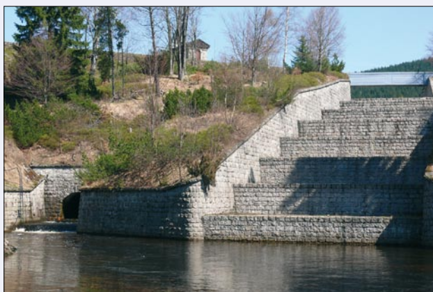
Obr. 73. Souš, kaskáda od bezpečnostního přelivu
