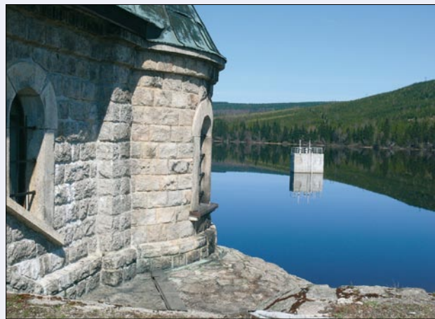
Obr. 72. Věžový odběrný objekt
