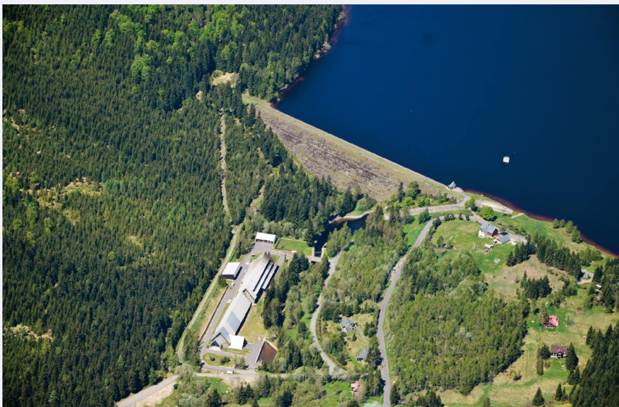
Obr. 67. Souš, letecký pohled na přehradu a úpravnu vody
