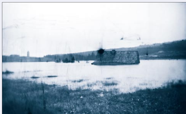
Obr. 54. Souš, povodeň, zátopa v prostoru budoucí nádrže, 1913
