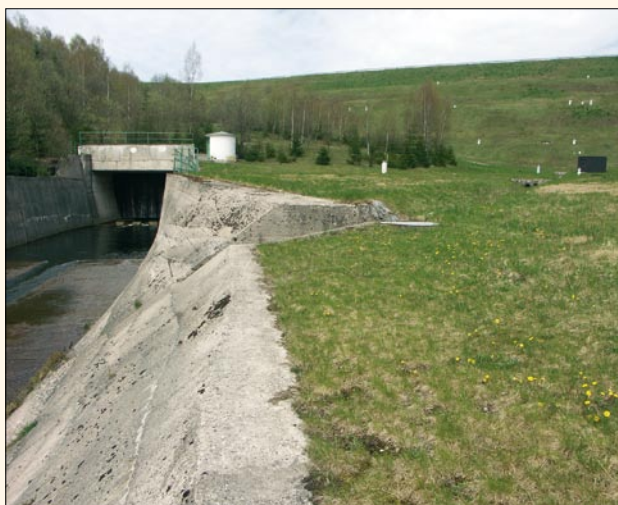
Obr. 85. Josefův Důl, vyústění odpadního tunelu od spodních výpustí
