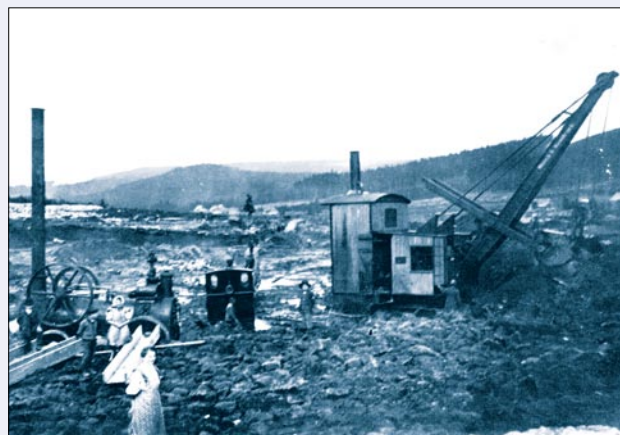
Obr. 59. Souš, parní bagr, lokomobila a polní dráha, 1913
