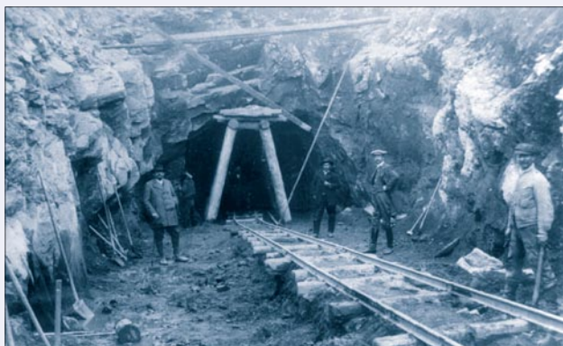
Obr. 53. Souš, vyústění spojovací štolý pro budoucí převod vody z nádrže přehrady na Bílé Desné, 1912
