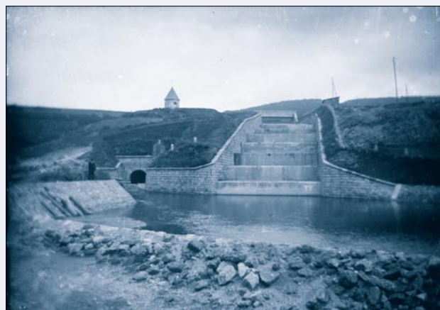
Obr. 61. Souš, kaskáda od bezpečnostního přelivu po dokončení, 1915
