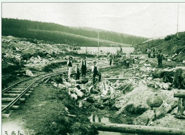
Obr. 19. Bílá Desná, výstavba hráze pro odvedení vody z koryta v době výstavby, 1913
