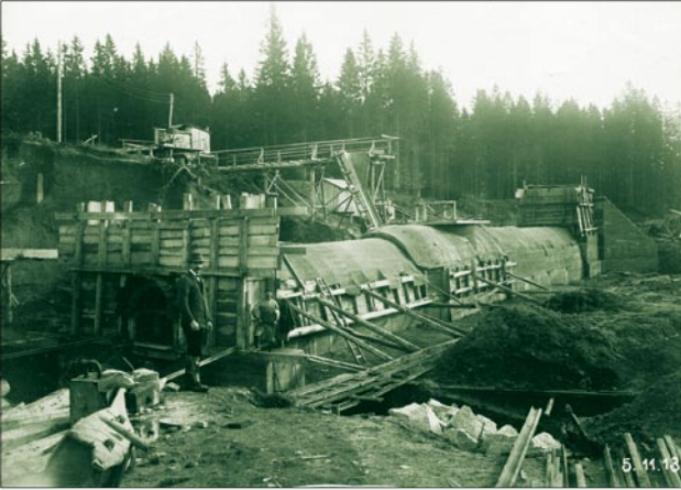
Obr. 21. Bílá Desná, vtok do výpustné štoly, 1913
