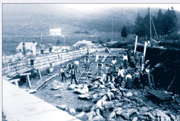
Obr. 56. Souš, zdění hrany bezpečnostního přelivu, 1913
