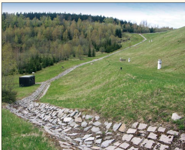
Obr. 84. Josefův Důl, vzdušný líc hlavní přehradní hráze
