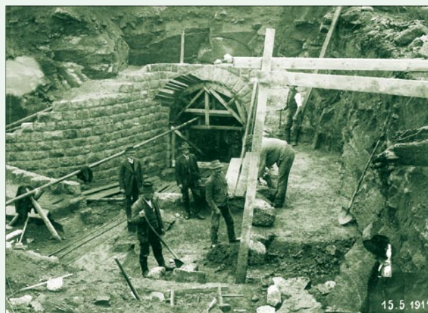
Obr. 28. Bílá Desná, zdění portálu vtokového objektu spojovací štoly, 1914
