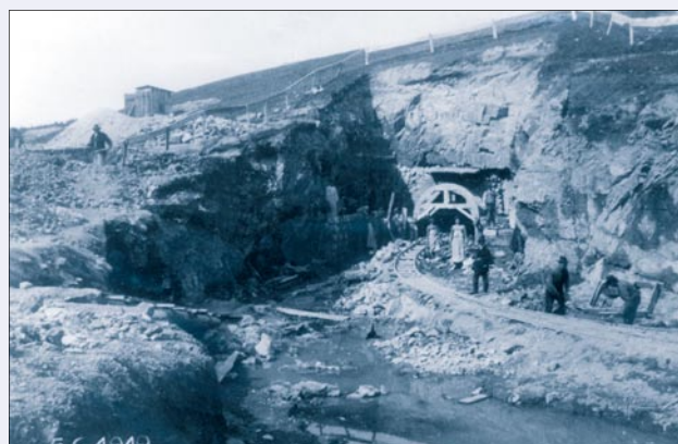
Obr. 52. Souš, výstavba výtokového objektu výpustné štoly, 1912
