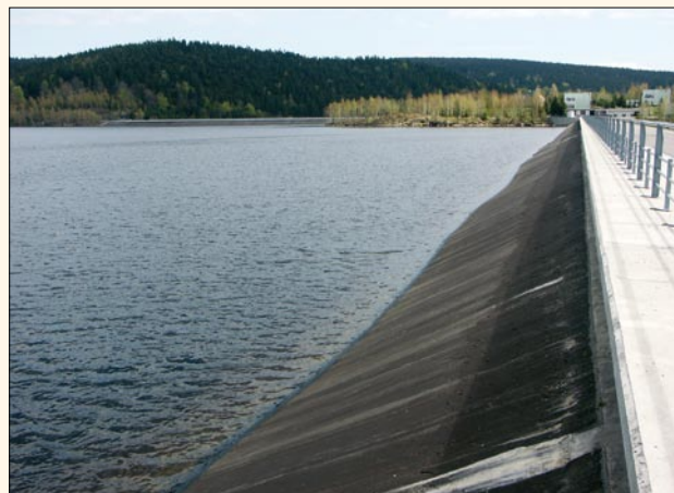
Obr. 82. Josefův Důl, asfaltbetonové těsnění návodního líce hlavní přehradní hráze
