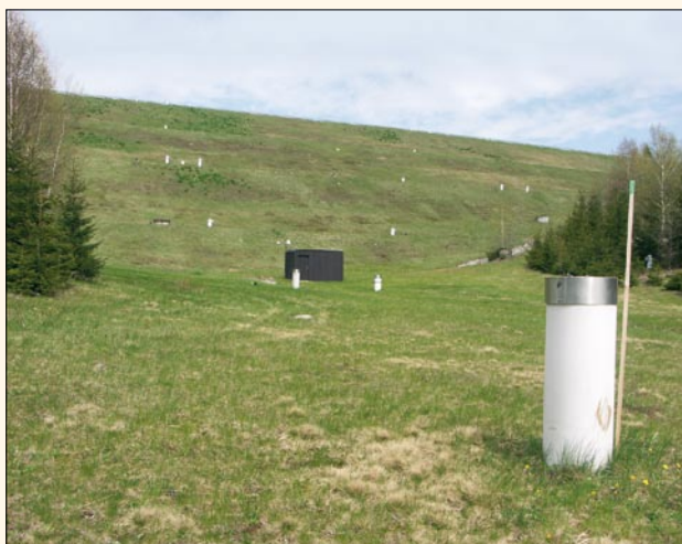
Obr. 87. Josefův Důl, vzdušný líc hlavní přehradní hráze s měřicími body
