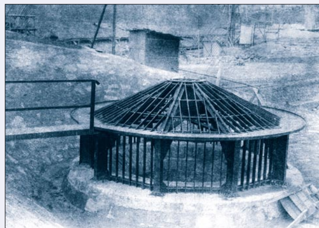
Obr. 66. Souš, vtokový objekt výpustné štol po rekonstrukci, 1927
