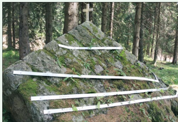
Obr. 39. Bílá Desná, památník obětem katastrofy umístěný v roce 2016 na odtrženém křídle výtokového objektu výpustné štoly
