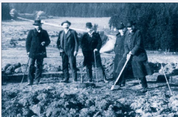
Obr. 51. Souš, slavnostní výkop, 1911
