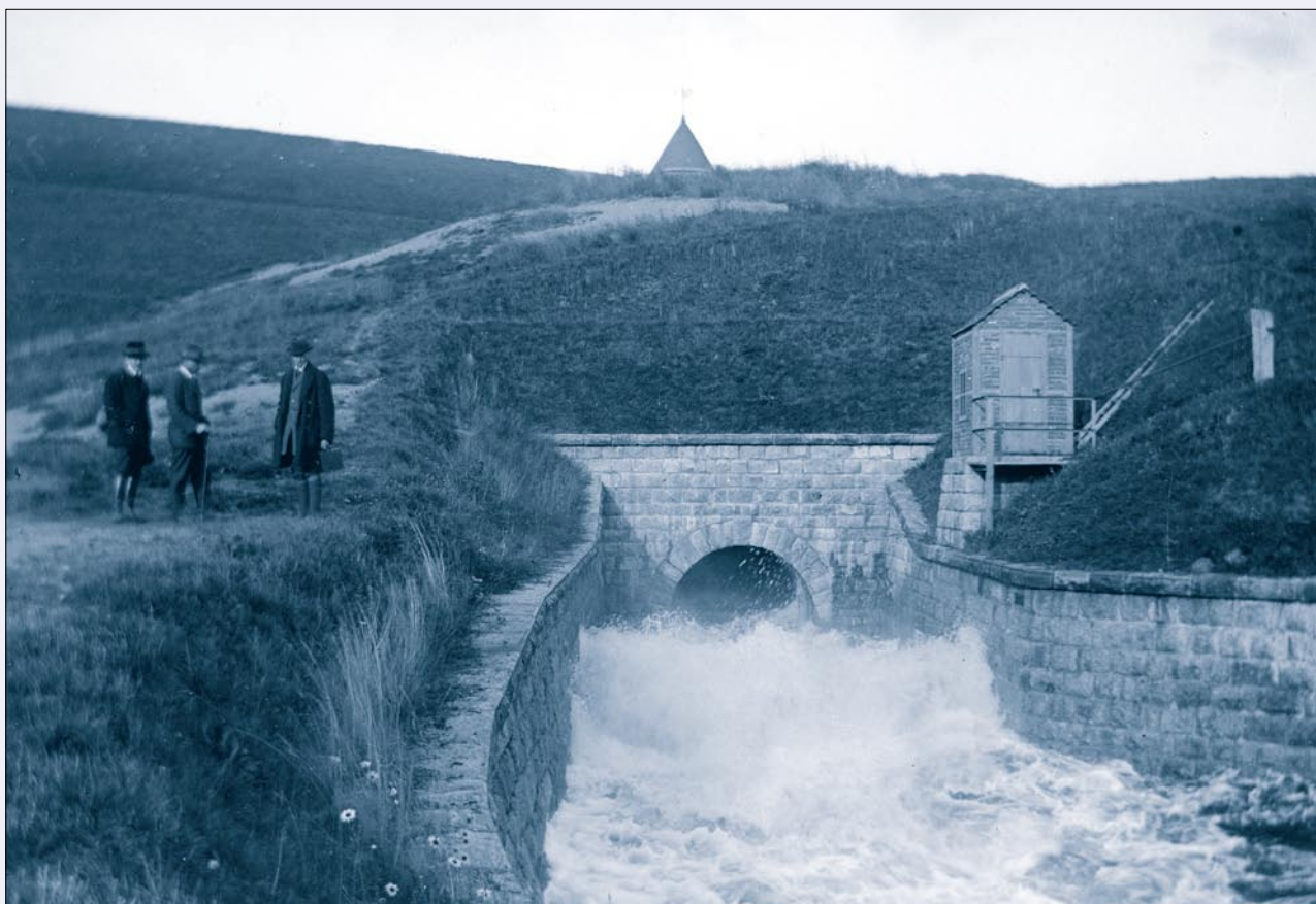
Obr. 62. Souš, výtokový objekt výpustné štoly, 1915
