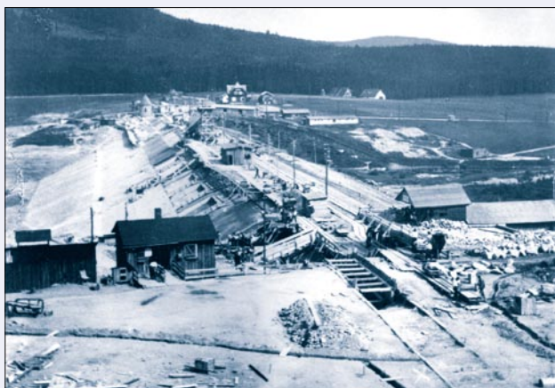
Obr. 60. Souš, pohled na staveniště přehrady, 1914
