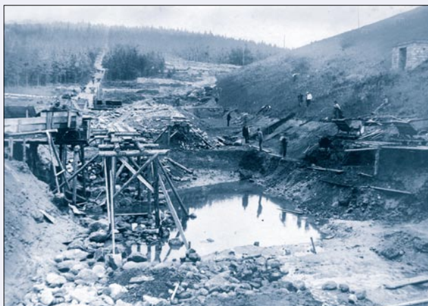
Obr. 65. Souš, rekonstrukce návodního líce přehrady, 1926
