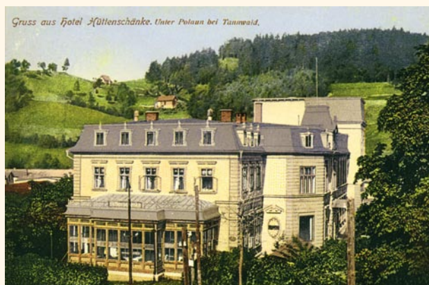
Obr. 10. Dolní Polubný, hotel Hüttenschänke, 1912
