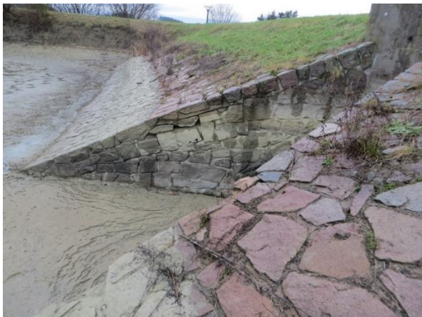
Hráz malé vodní nádrže v původním stavu a po provedené opravě
