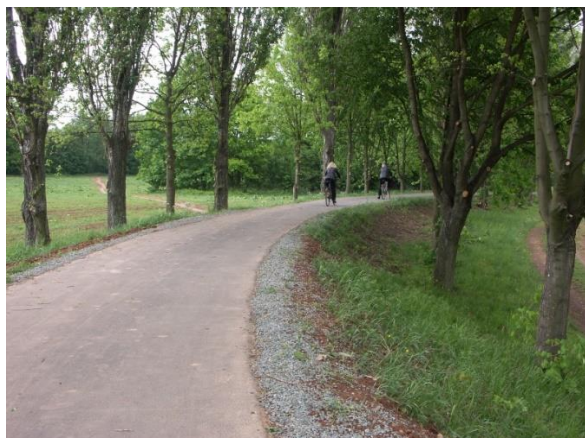
Zrekonstruovaná ochranná hrázka ve Třebší
