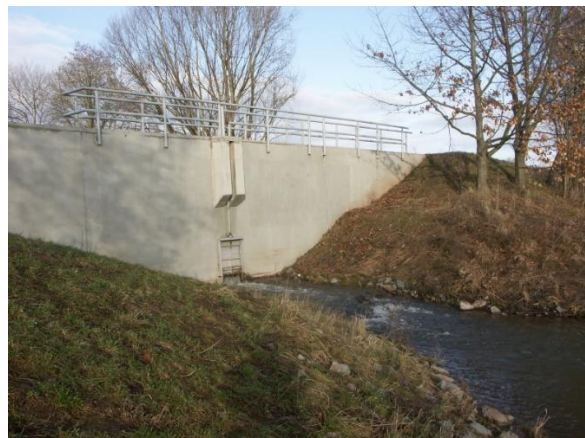
Inundační uzávěr na výtoku Velkého labského náhonu
