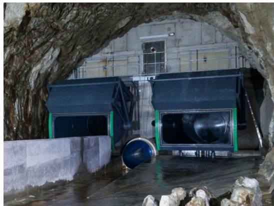
Nové spodní výpusti VD Labská
