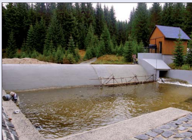
Bílá Desná, oprava jezu
