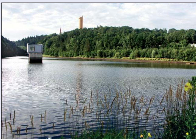
Chrudimka, nádrž Práčov, objekt pro odběr vody na úpravnu
