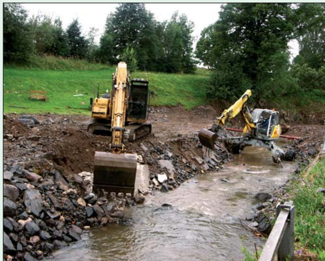
Oleška, Heřmanice, obnova koryta
