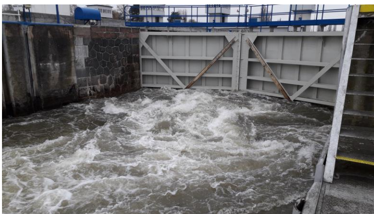
Dokončená stavba – prosinec 2020
