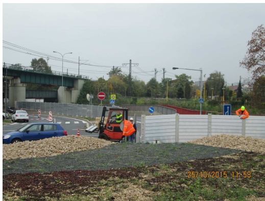
Obr. 3 : Cvičná instalace mobilního hrazení v Ústí nad Labem
