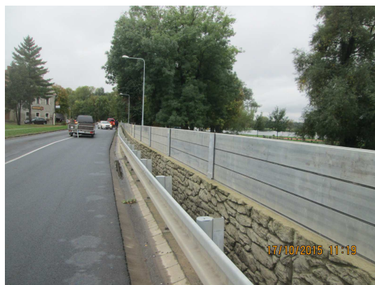
Obr. 2 : Cvičná instalace mobilního hrazení v obci Křešice
