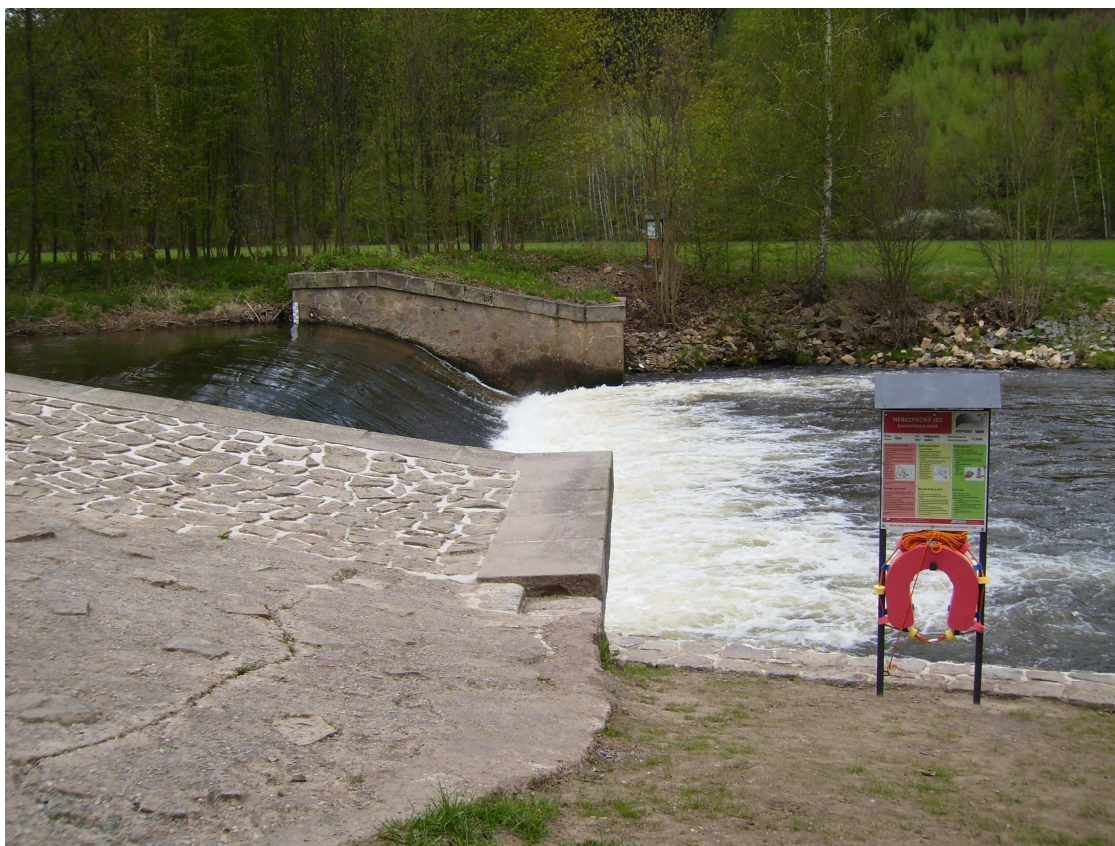
Obr. 2 : Varovné tabule na Viktorčině splavu na řece Úpě
