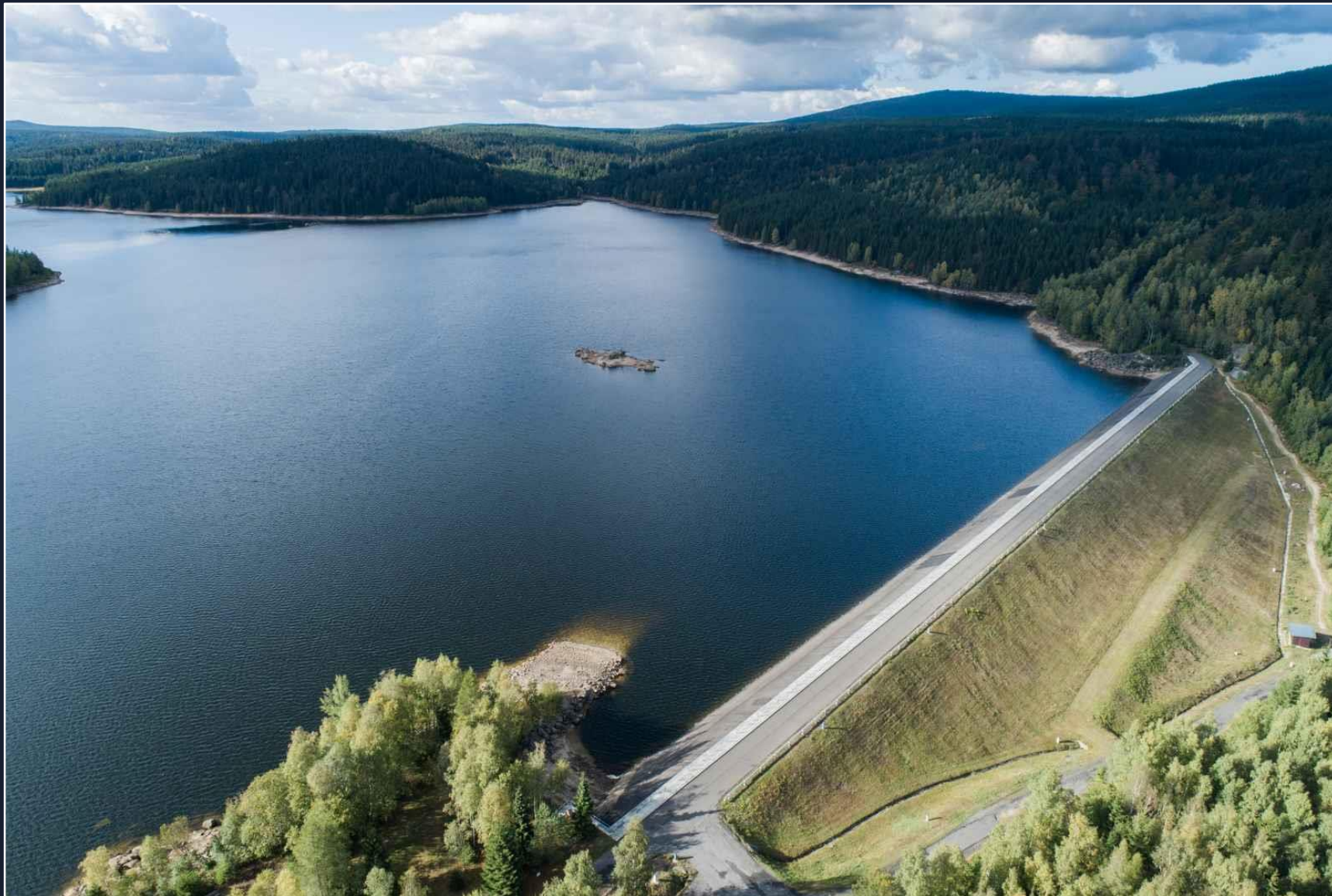
Boční hrází je přehrazeno levostranné terénní sedlo, její výška je 15 m nad základovou spárou.
