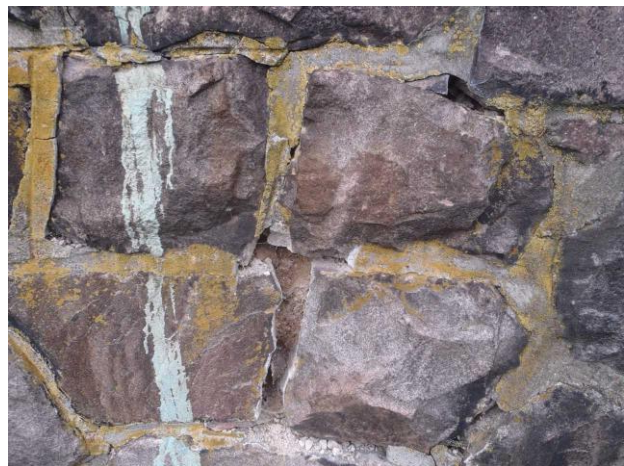
Stavebně-technický průřez stávajícího stavu: Vlevo chybějící spárování až do hl. 300 mm, vpravo pouze povrchové spárování, postupně odpadávající
