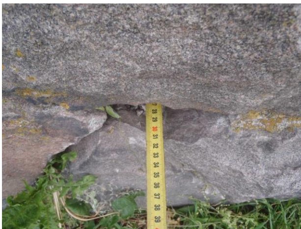
Stavebně-technický průřez stávajícího stavu: Vlevo chybějící spárování až do hl. 300 mm, vpravo pouze povrchové spárování, postupně odpadávající
