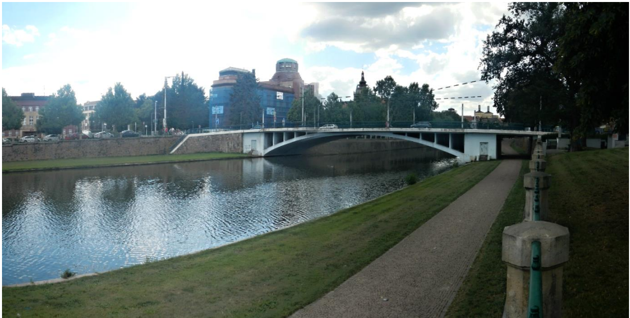
Celkový pohled na prostor stavby – předpolí Tyršova mostu
