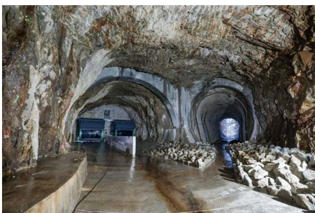
Nové spodní výpustí v obtokovém tunelu
