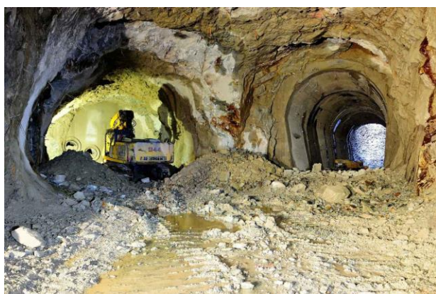
Bourání spodních výpustí v obtokovém tunelu
