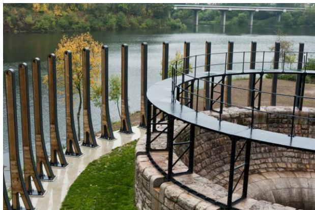
Detail nové ochrany šachtového přelivu
