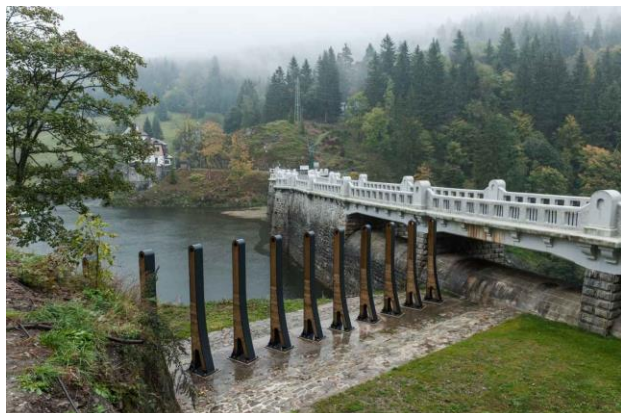
Hráz VD Labská a nová ochrana korunového přelivu
