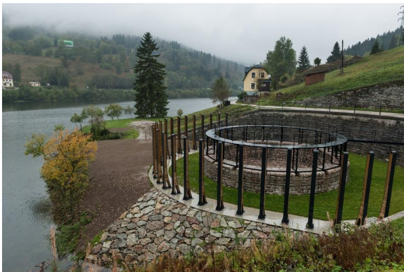
Nově vybudovaná ochrana šachtového přelivu
