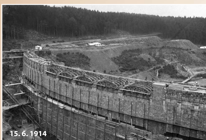
Dřevěné konstrukce pro klenby přemostění přelivů
