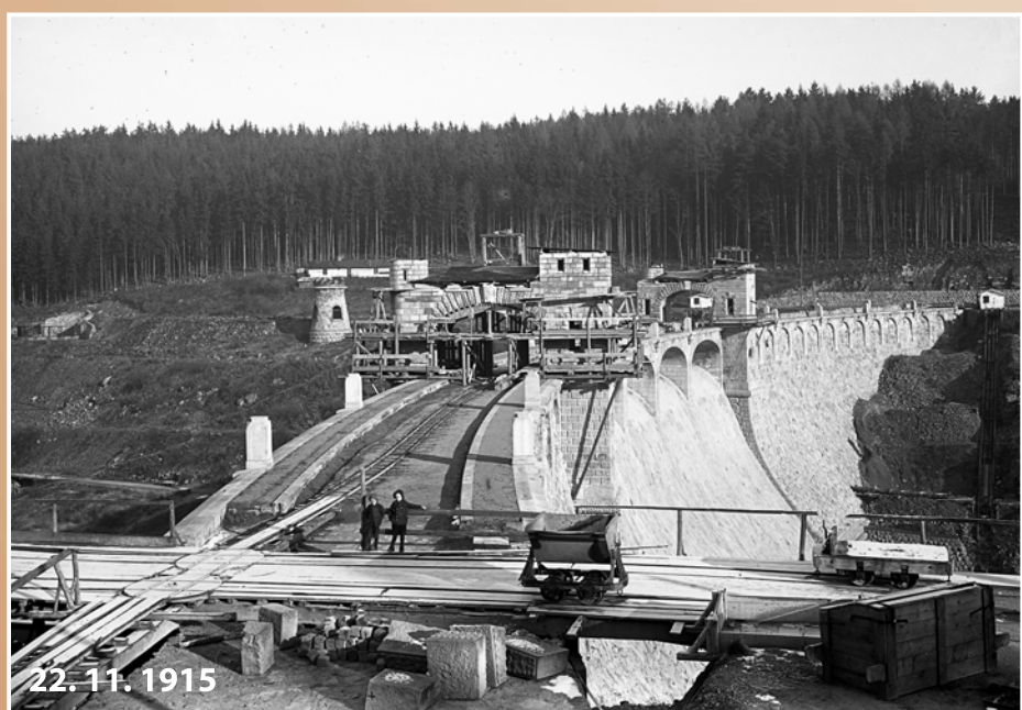
Hráz s rozestavěnými bránami
