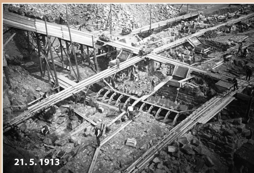
Zdění hráze na úrovni spodních výpustí
