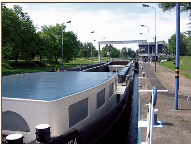
Labe, plavební komora v Lobkovicích
