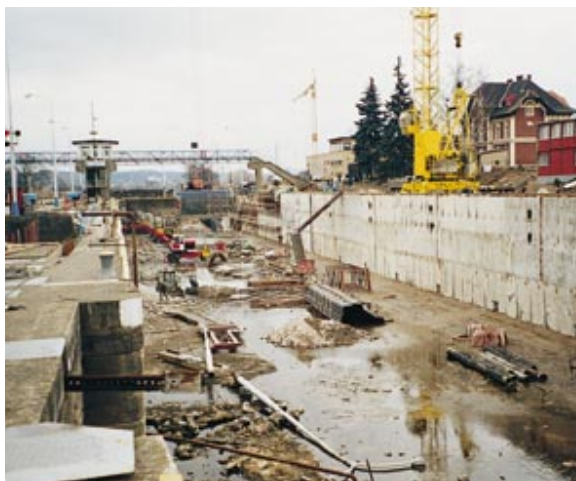
Rekonstrukce velké plavební komory ve Štětí
