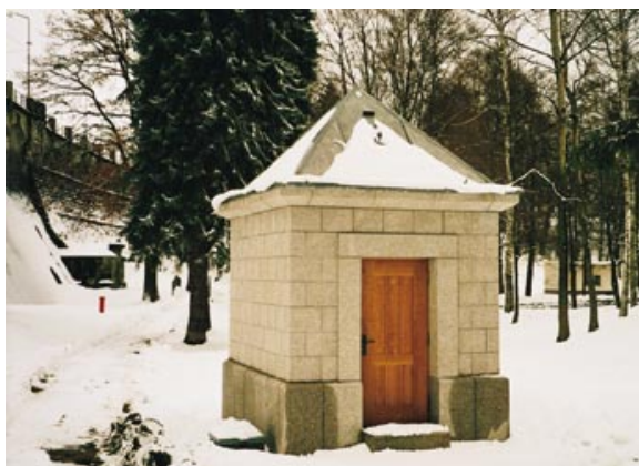
Vstupní objekt do injekční štoly na VD Mšeno
