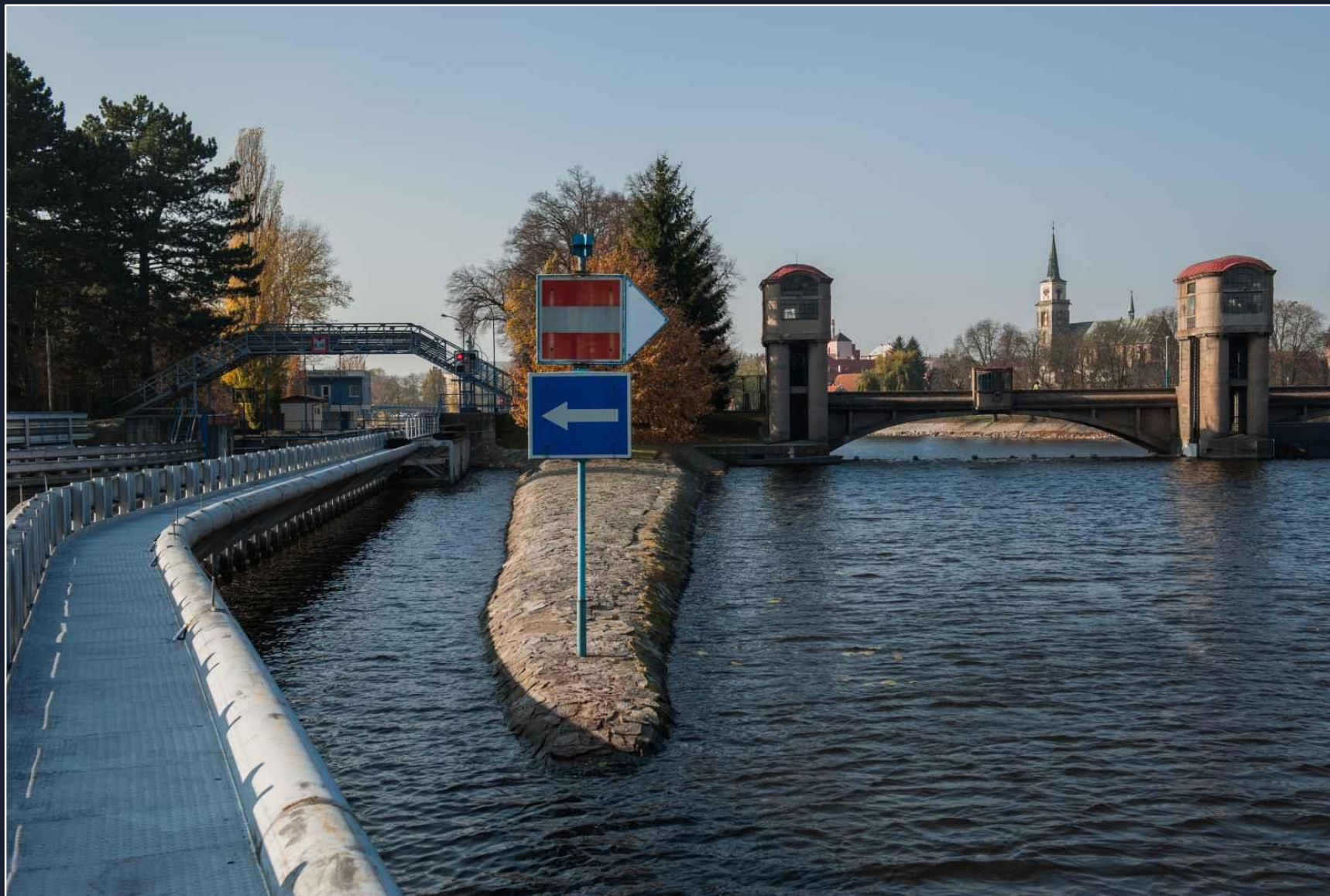
Plavební komora se nachází při levém břehu řeky, od jezu je oddělena úzkým ostrovem.
