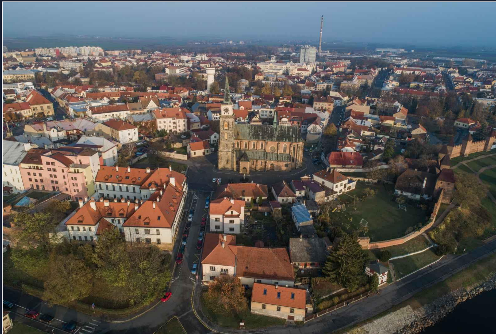
Zdymadlo se nachází v blízkosti centra Nymburka s městskými hradbami a kostelem sv. Jiljí.
