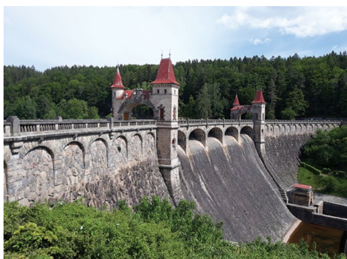
Hráz přehrady po rekonstrukci průjezdových bran
