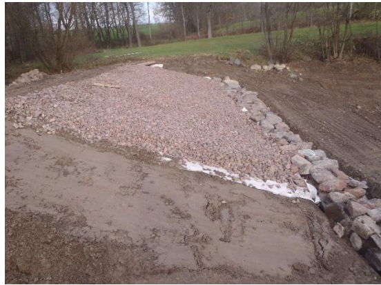
Těžení sedimentu, zakládání sdruženého objektu a opevňování návodního líce hráze
