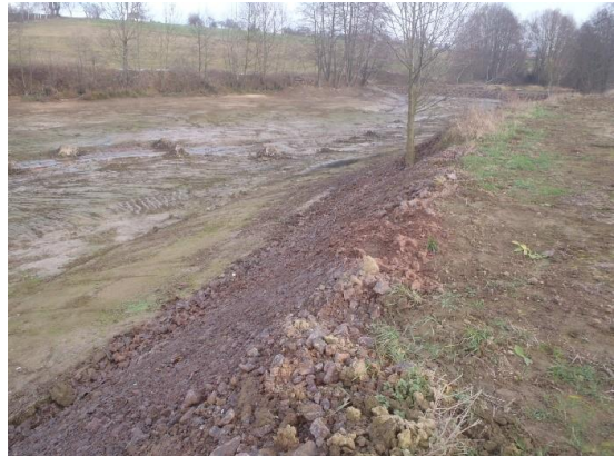
Těžení sedimentu, zakládání sdruženého objektu a opevňování návodního líce hráze
