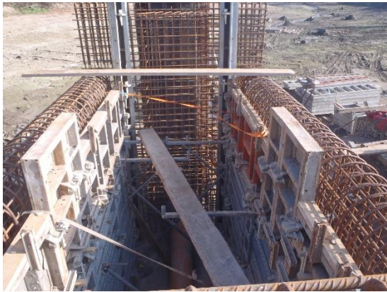
Těžení sedimentu, zakládání sdruženého objektu a opevňování návodního líce hráze
