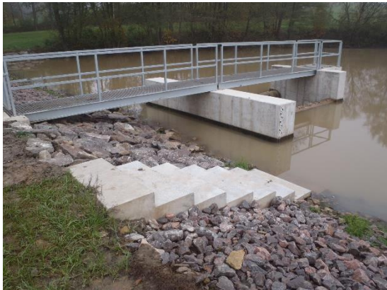
Těžení sedimentu, zakládání sdruženého objektu a opevňování návodního líce hráze
