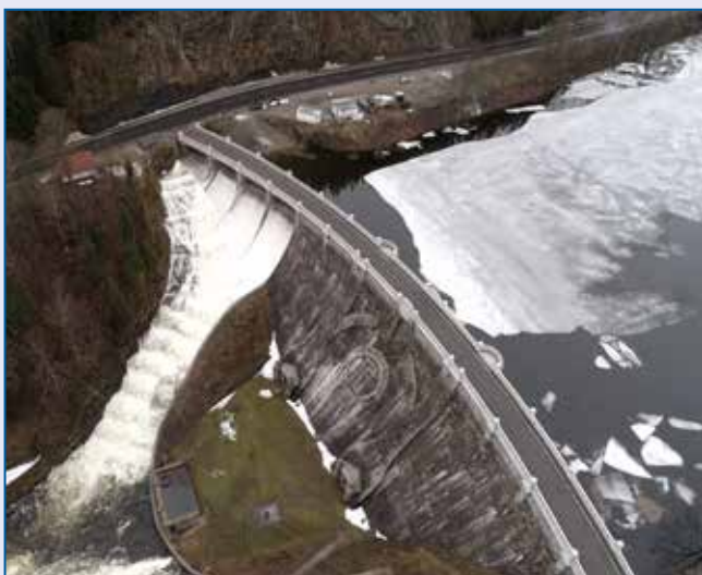
VD Labská, převádění průtoku korunovými přelivy
