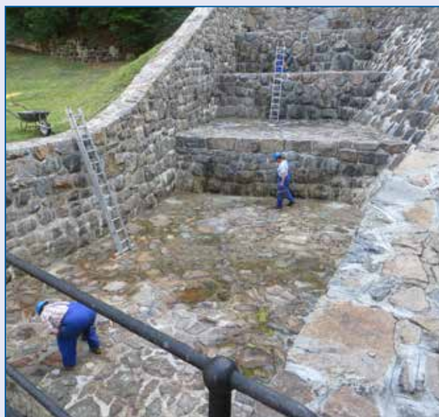
VD Pařížov, oprava spárování kaskády pod korunovým přelivem
