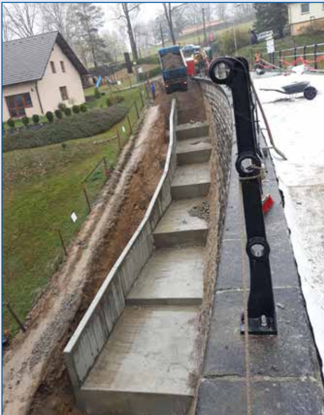
VD Fojtka, zřízení nouzového přelivu
