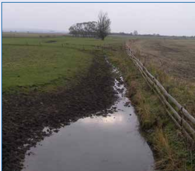
Smíchovský potok, Chotěšice, poškození upraveného břehu chovanými zvířaty
