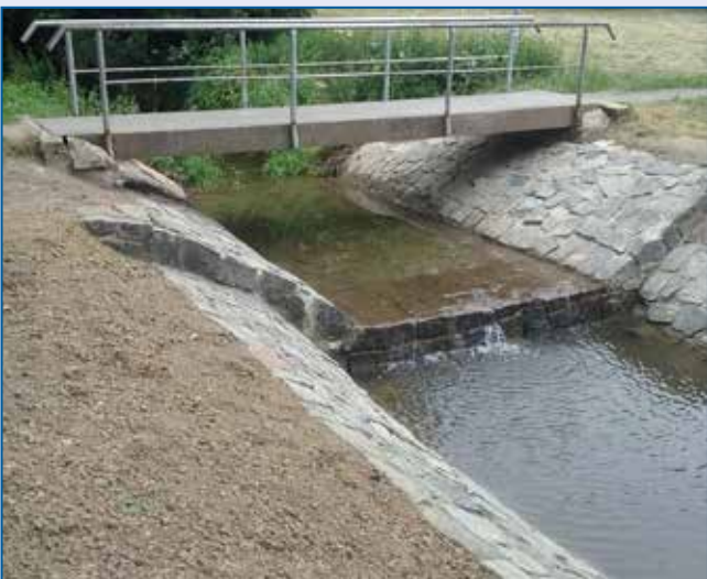
Lukavický potok, Letohrad, koryto po rekonstrukci
