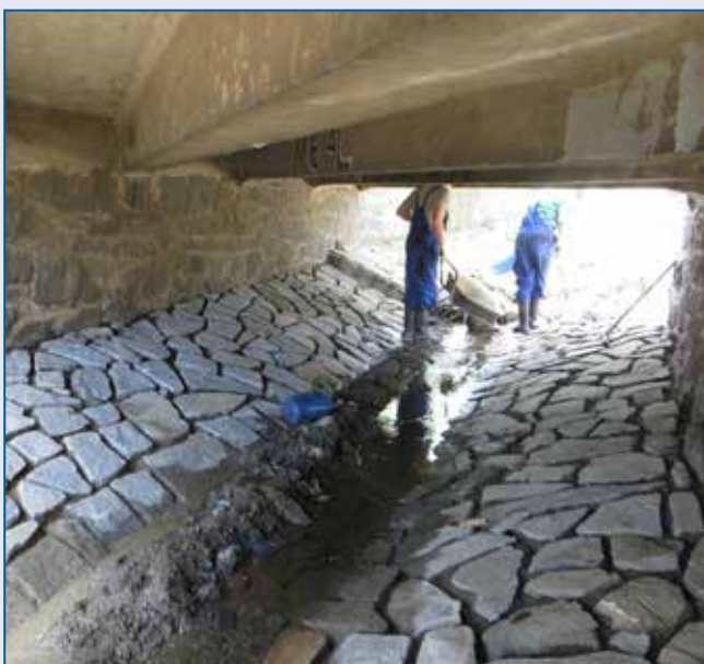
Dolský potok, Pokřikov, oprava dlažeb
