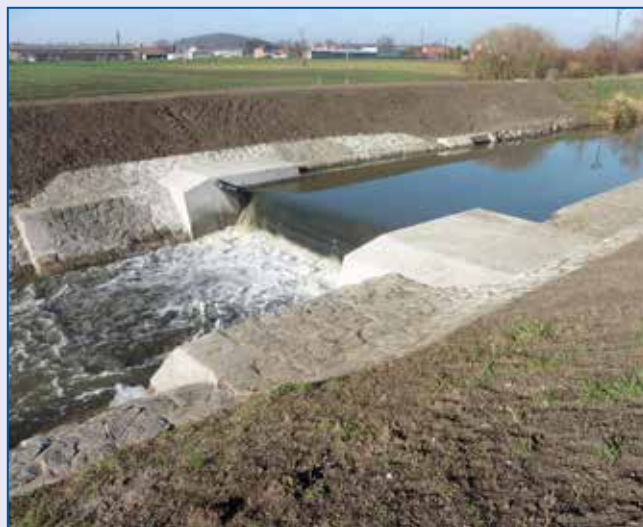
Mrlina, Zábrdovice, jez po rekonstrukci
