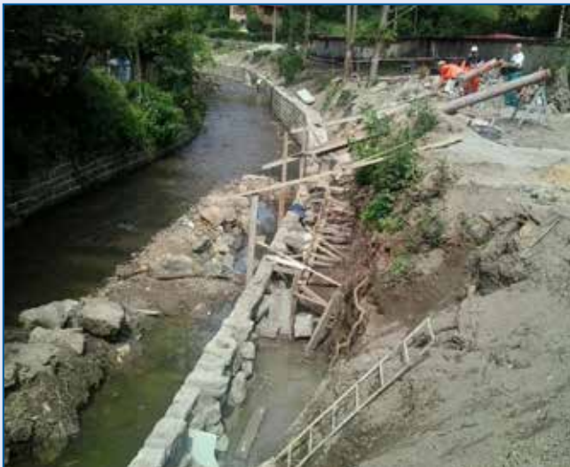
Lužická Nisa, Proseč, oprava koryta
