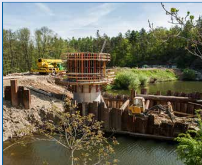
VD Velký rybník, obnova spodních výpustí
