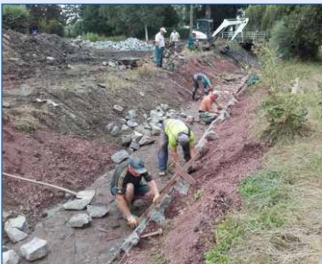
Černilovský potok, oprava dlažeb
