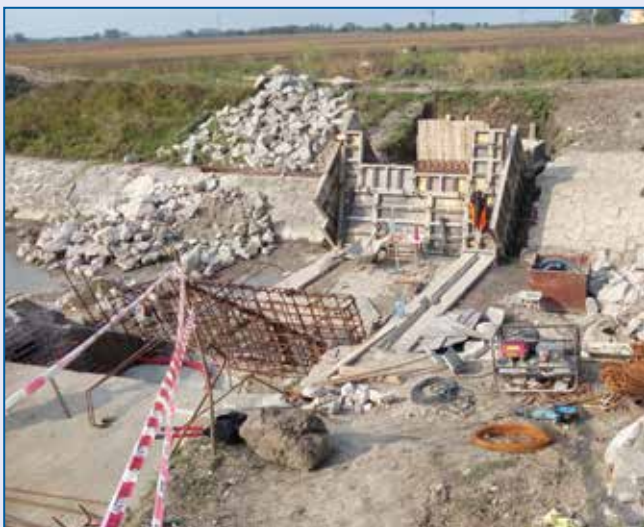
Mrlina, Zábrdovice, jez v průběhu rekonstrukce
