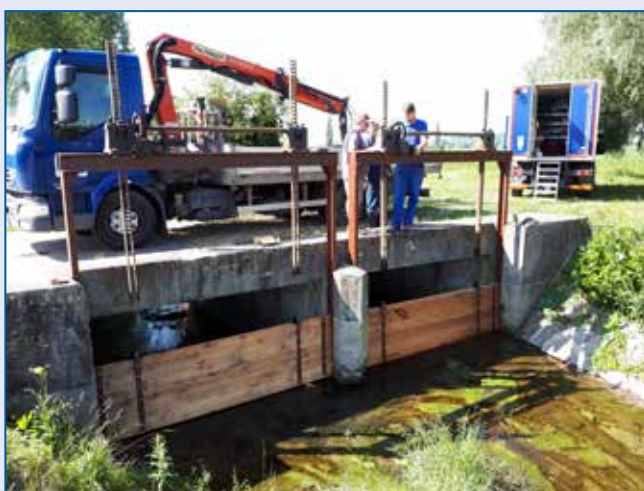
Jordán, Rožnov, oprava stavidel
