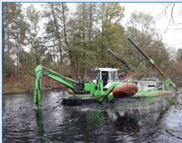
Revitalizace slepého ramene Orlice v Malšově Lhotě, odstraňování sedimentu sacím bagrem
