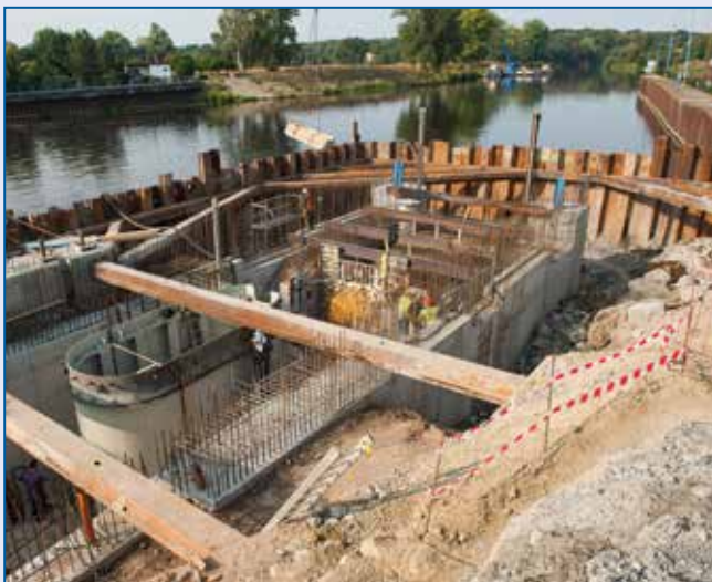
Labe, Veletov, rekonstrukce a modernizace MVE
