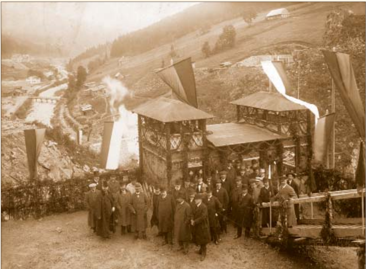
Abb. 43 Kontrolltag an der Talsperre Labská, 1912
