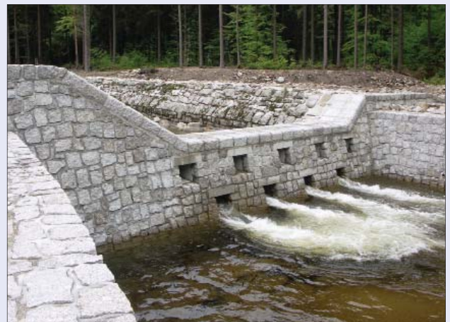
Abb. 62 Große Geröllsperre im Elbgrund
