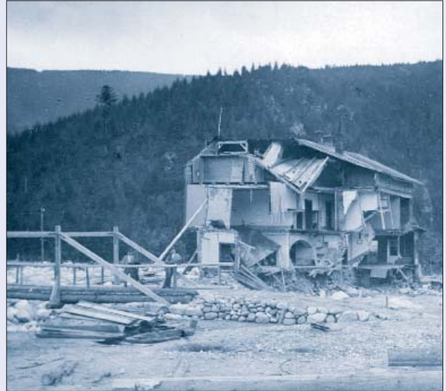
Abb. 35 Provisorischer Steg am eingestürzten Hotel „Deutscher Kaiser“ in Špindlerův Mlýn, 1897
