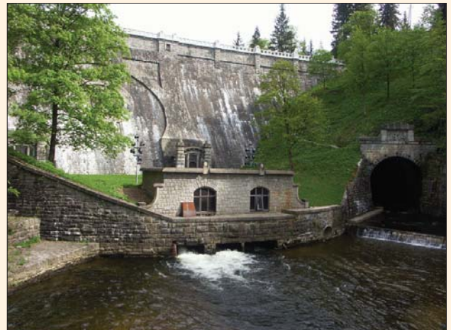
Abb. 49 Luftseite der Staumauer
