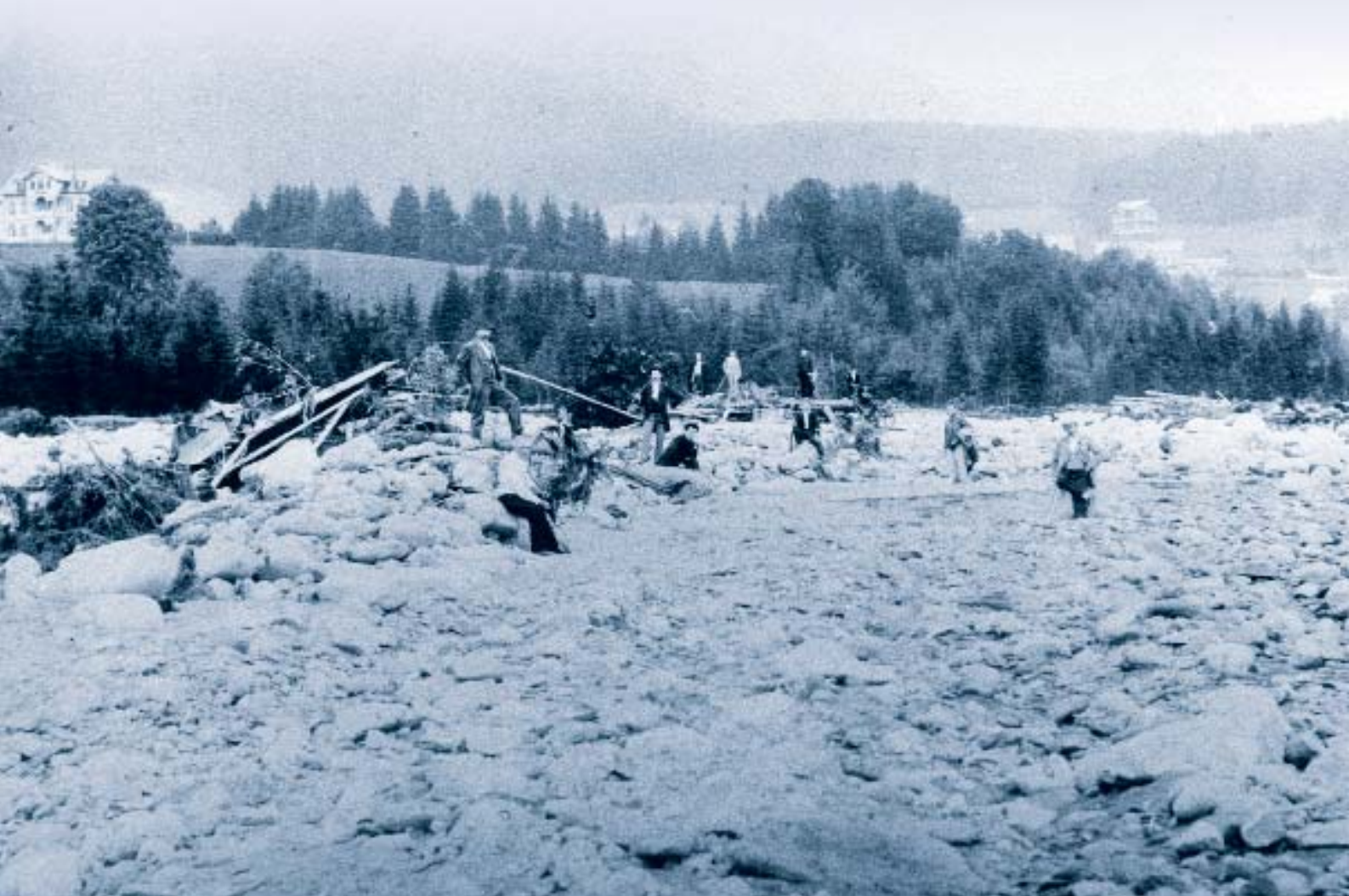
Abb. 36 Anschwemmungen im Flussbett der Elbe bei Špindlerův Mlýn, 1897
