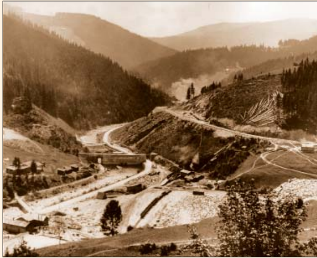
Abb. 44 Stand der Arbeiten im Jahre 1911
