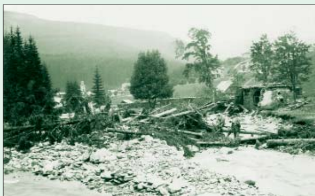
Abb. 24 Gewässerbett des Dolský potok (Klausenwasser) in Svatý Petr nach dem Hochwasser 1897
