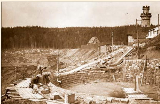
Abb. 56 Abschlussarbeiten am Schachtüberfall auf dem rechten Ufer, 1912
