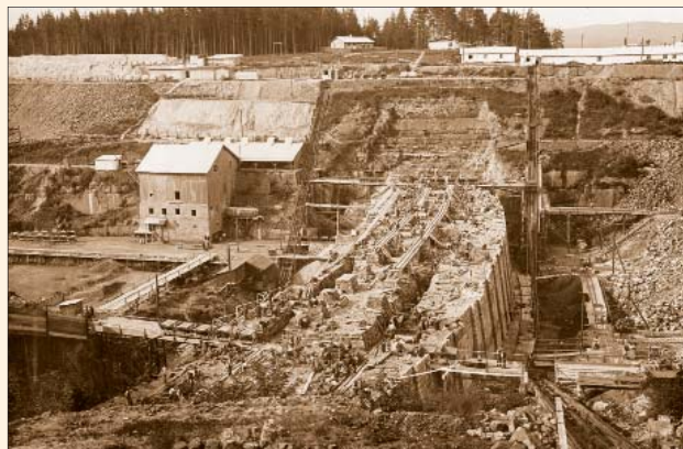
Abb. 57 Stand der Arbeiten im Jahre 1913
