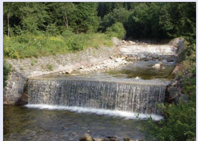
Abb. 64 Kaskade der Geröllsperren an der Elbe am Mädelsteg
