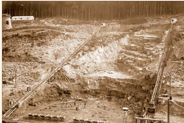
Abb. 55 Linkselsebische Einkerbung zur Einbindung der Staumauer, 1912
