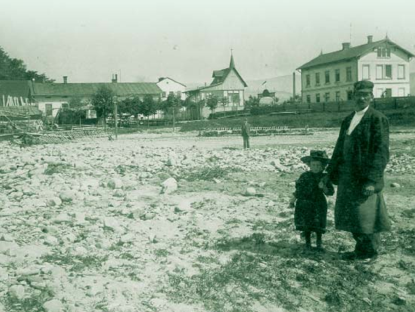
Abb. 28 Schwemmgut in der Gleisanlage am Bahnhof in Vrchlábi, 1897
