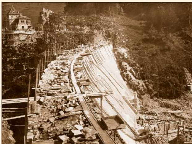
Abb. 48 Stand der Arbeiten im Jahre 1914
