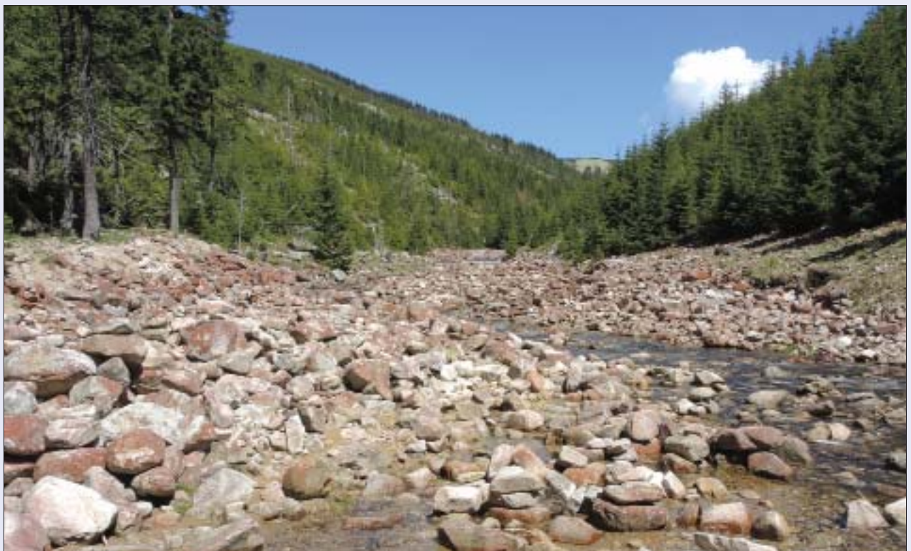
Abb. 75 Staubecken der Geröllsperre am Čertova strouha (Teufelsgraben)
