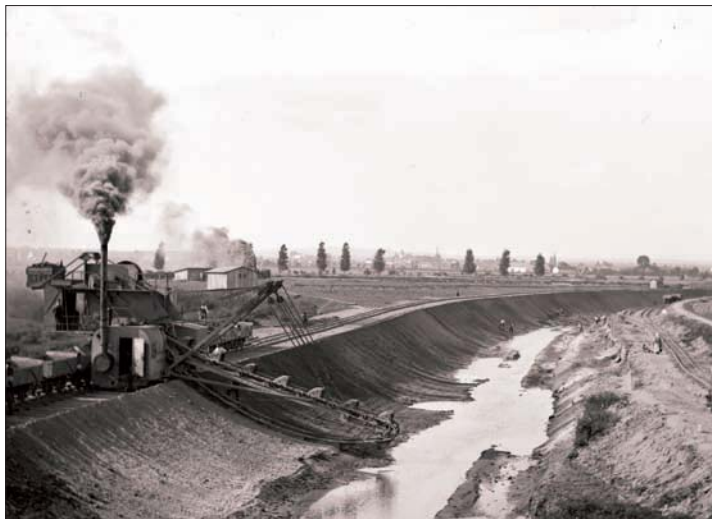
Hloubení nového koryta nad mostem železniční tratě do Týniště nad Orlicí, 1909 (Povodí Labe)
