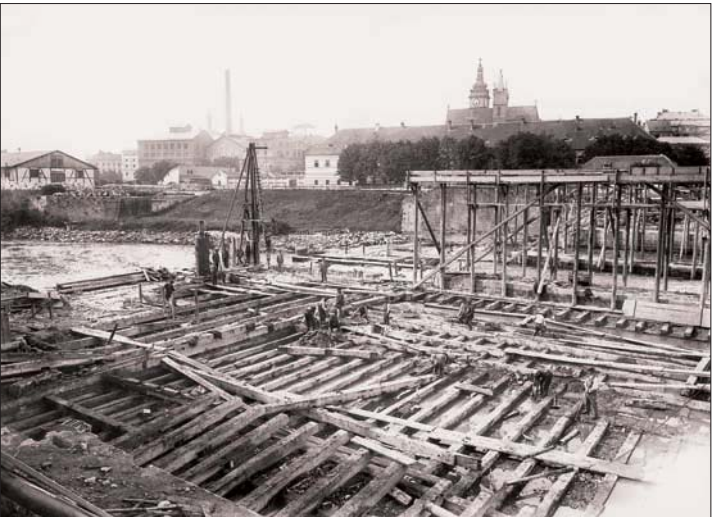
Bourání roštu pod pevnostním moravským mostem, 1910 (Muzeum východních Čech)
