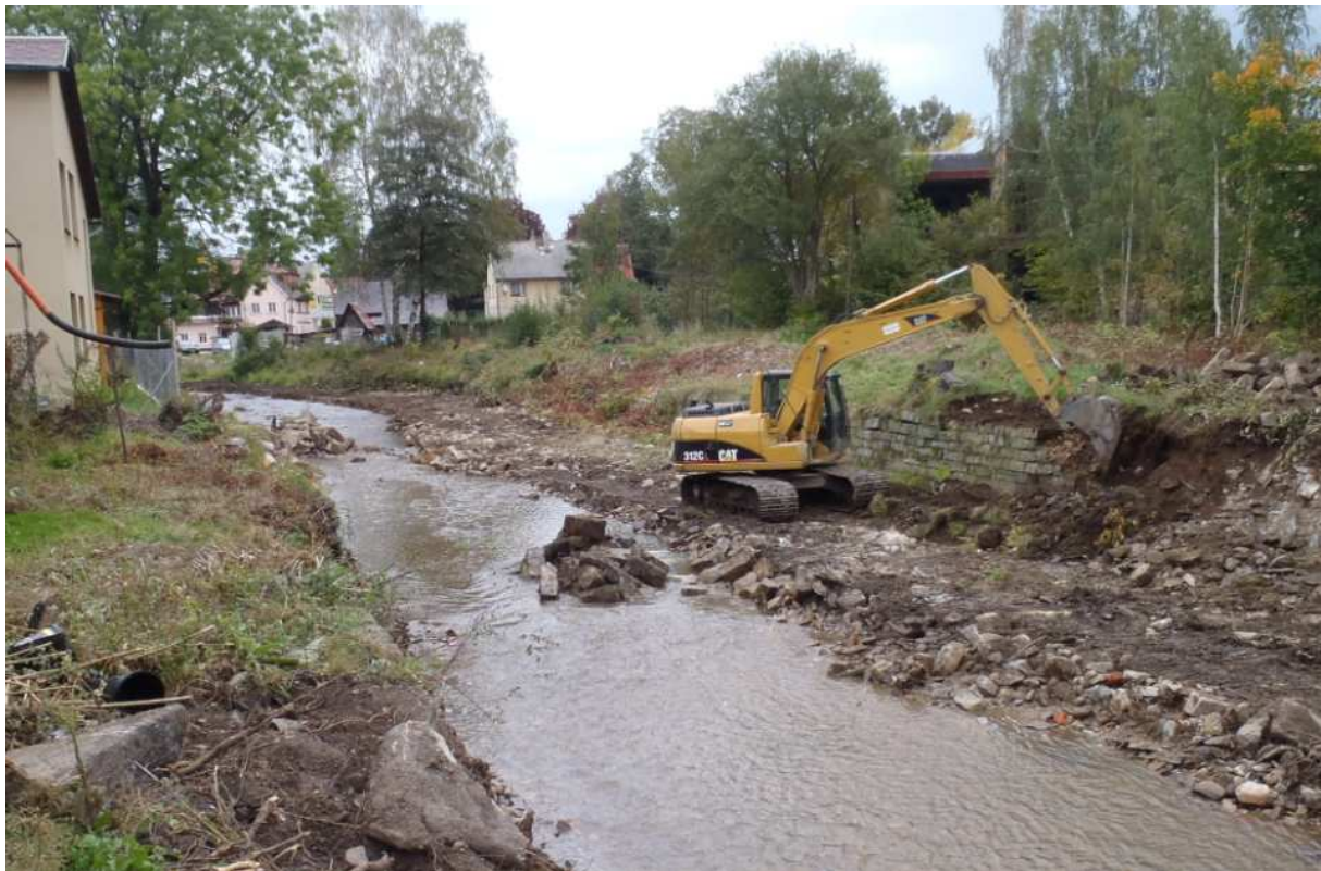
Obr. č. 1: Vodní tok Jeřice v Chrastavě před zahájením prací (říjen 2012)
