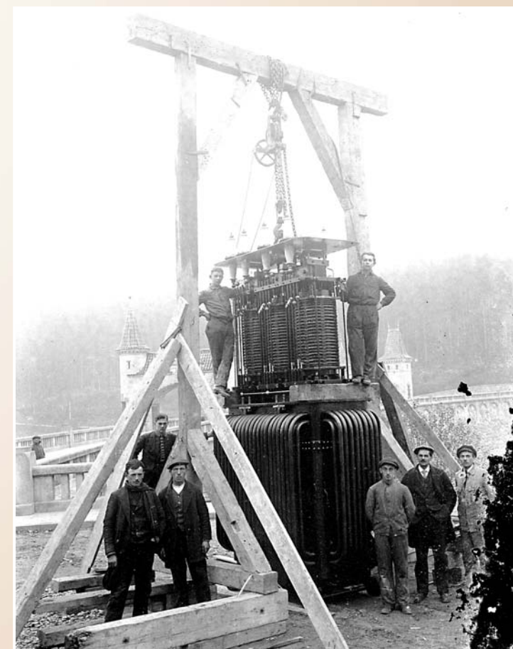
Přeprava transformátoru do elektrárny
