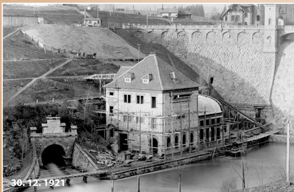
Postup stavby budovy vodní elektrárny
