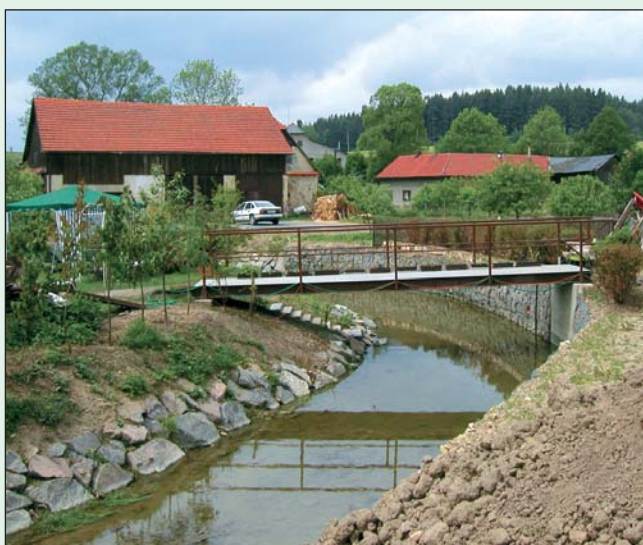
Úprava Třebovky v Opatově
