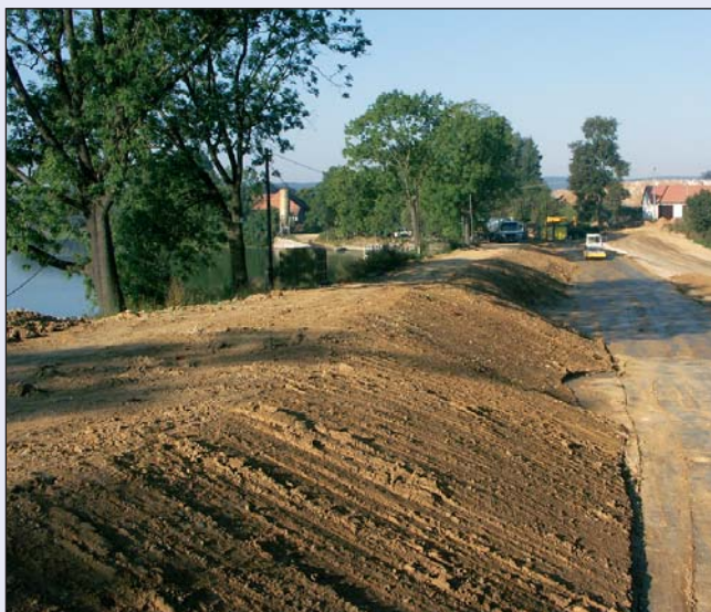
Rekonstrukce hráze rybníka Hvězda na Třebovce
