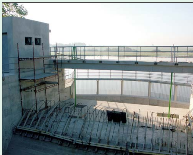
Rozestavěný objekt přelivu na rybníku Hvězda
