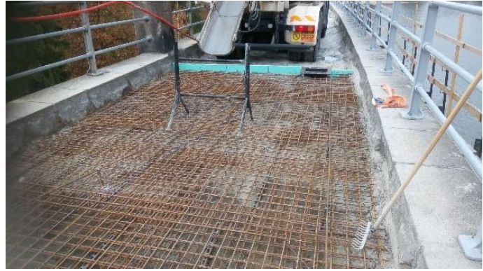
Ocelová výztuž desky
