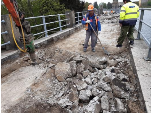
Bourání původního betonového podkladu
