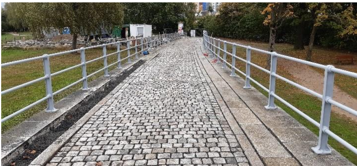
Dlažba před dokončením
