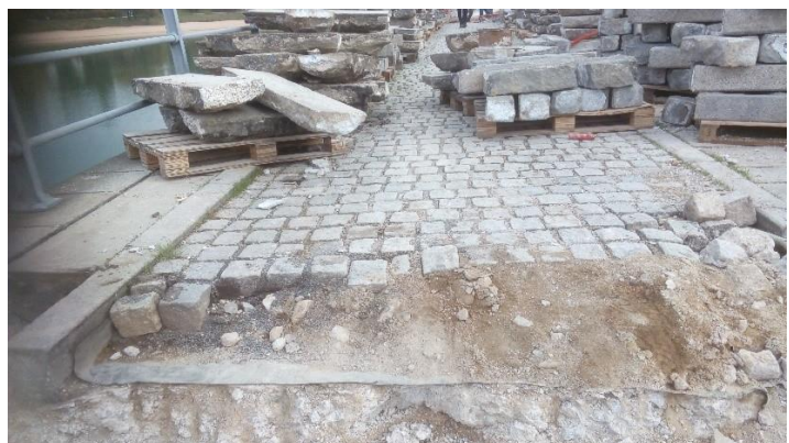
Demontované obrubníky a chodníkové kameny
