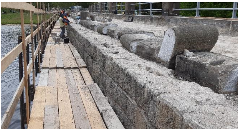
Demontované římsové kvádry
