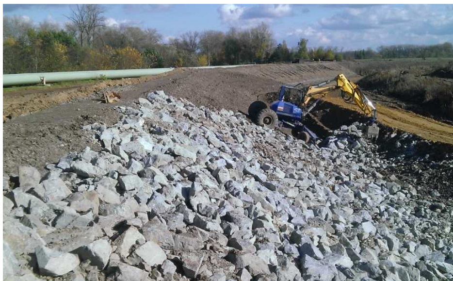
Obr. 3 Rozestavěné dílo při povodni v 06/2013
