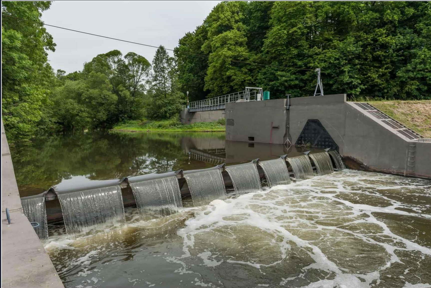
Jez má jedno pole šířky 20 m hrazené ocelovou dutou klapkou výšky 3,15 m, kterou lze ovládat z místa, dálkově z kanceláře jezného nebo automaticky dle stavu hladiny. Jez má vývar dlouhý 20,5 m a hluboký 1,6 m, nebezpečný pro vodáky i plavce.
