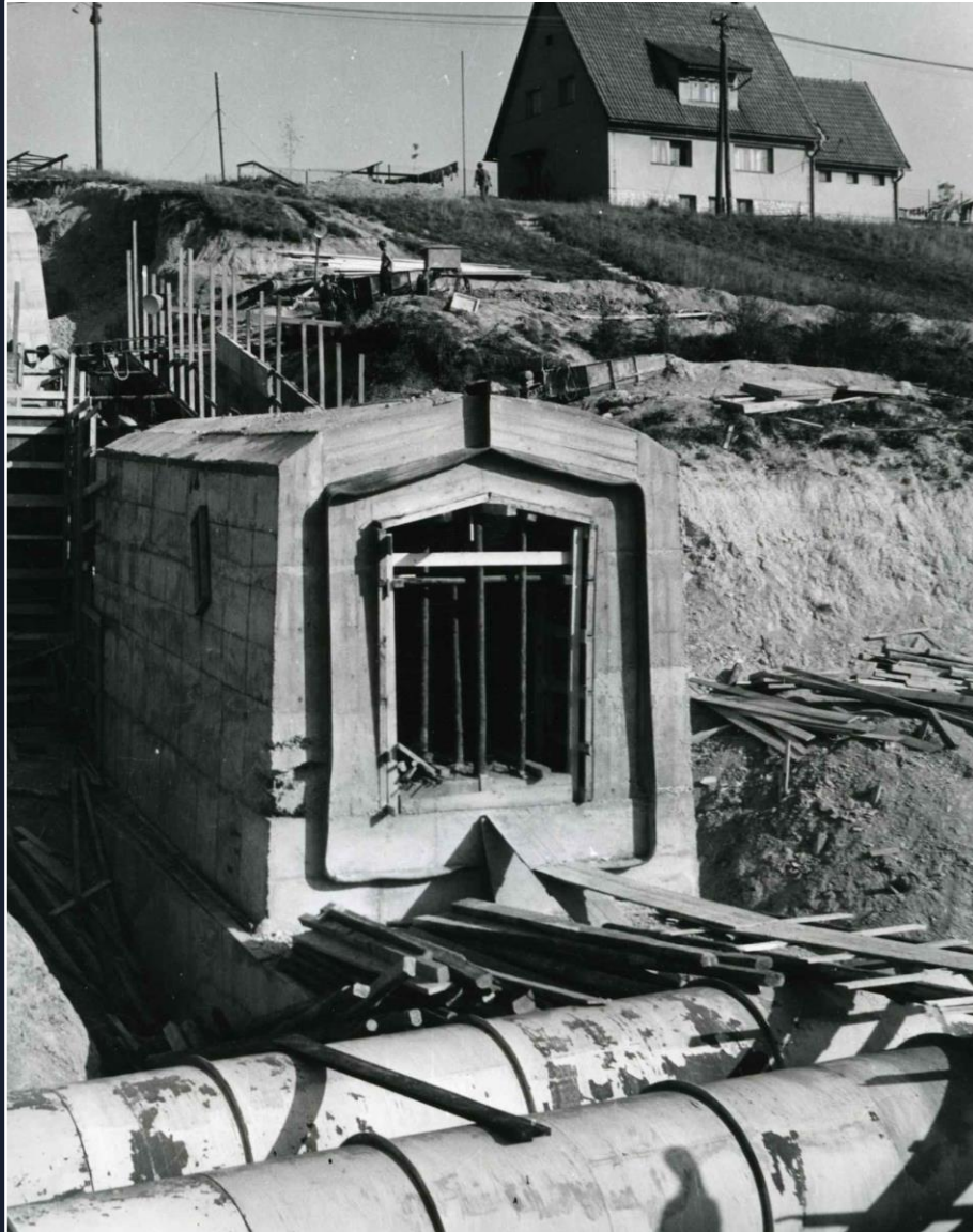
Výstavba přehrady proběhla v letech 1965 – 1972. Na snímcích vlevo injekční chodba (1966), vpravo navážení hráze (1967).
