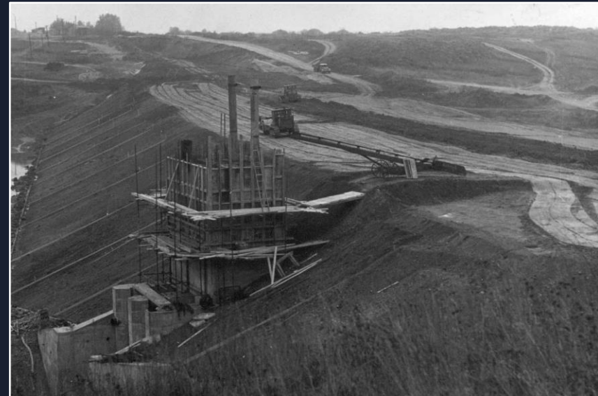
Výstavba přehrady proběhla v letech 1965 – 1972. Na snímcích vlevo injekční chodba (1966), vpravo navážení hráze (1967).
