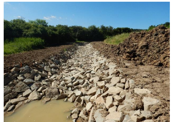
Dočasná tůň, těžení sedimentu, opevňování břehů, požerák s výtokovým potrubím před obetonováním, bezpečnostní přeliv a opevňování koryta v podhráží s vývarem.
