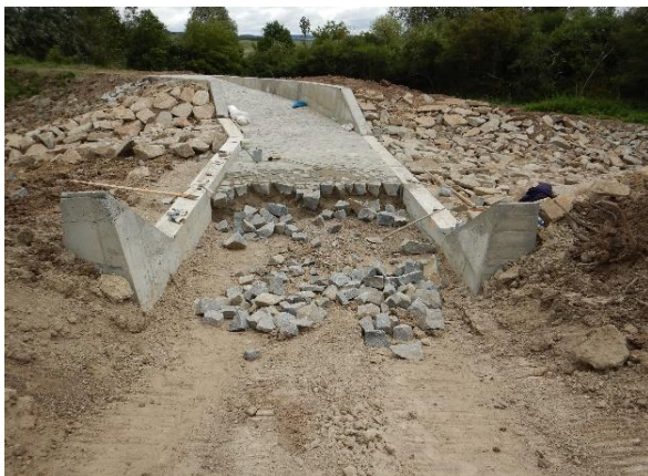
Dočasná tůň, těžení sedimentu, opevňování břehů, požerák s výtokovým potrubím před obetonováním, bezpečnostní přeliv a opevňování koryta v podhráží s vývarem.
