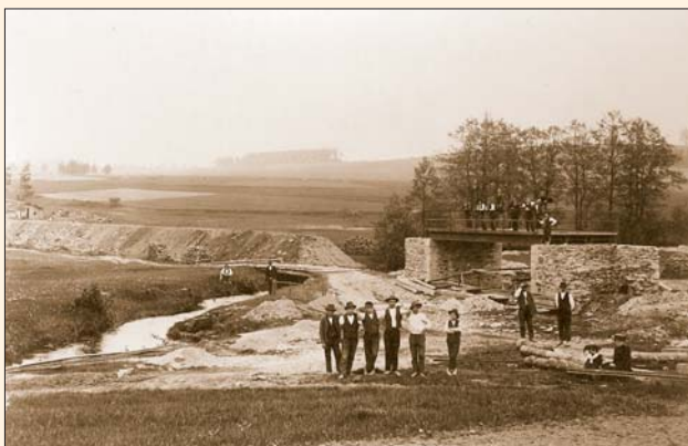
Obr. 29 Stavba mostu přes Chrudimku u Ovčina, 1908
