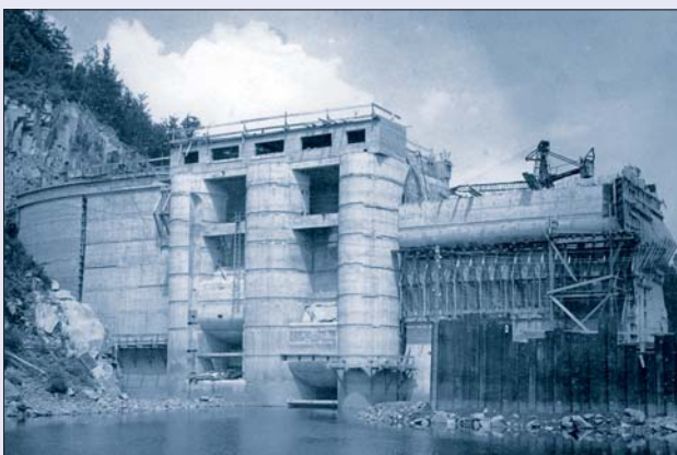
Obr. 81 Rozestavěný funkční blok, 1951
