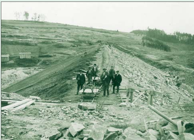
Obr. 44 Rozestavěná sypaná hráz, 1910
