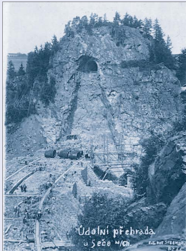
Obr. 69 Rozestavěná přehradní hráz, 1930
