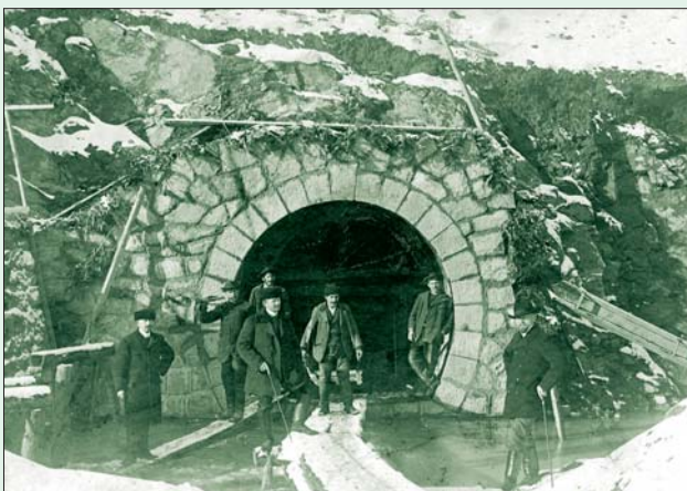
Obr. 46 Obezdný výtok z obtokového tunelu, 1910
