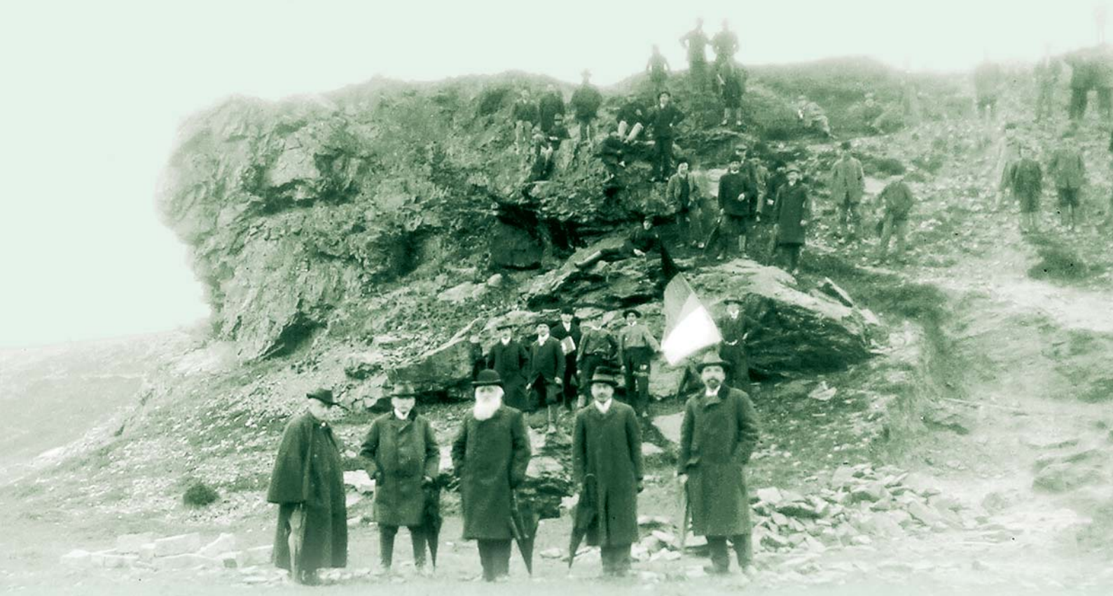
Obr. 39 Hamry, před prvním odpálením nálože v místě budoucího obtokového tunelu, 15. listopadu 1907
