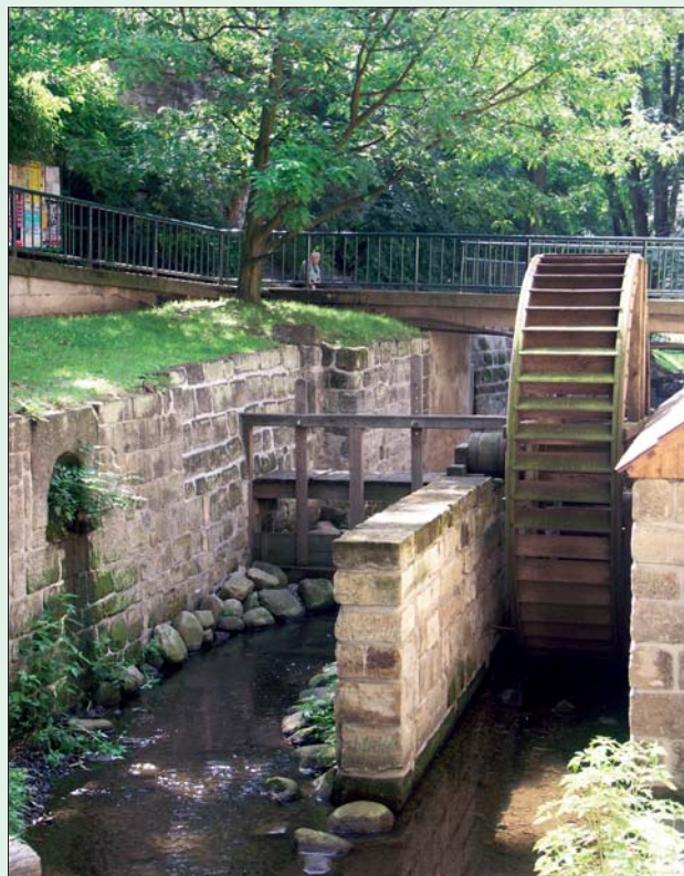
Obr. 7 Obnovené vodní kolo u bývalého Polívkova mlýna v Chrudimi
