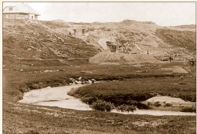
Obr. 37 Chrudimka nad stavenišťem přehrady Hamry, 1909
