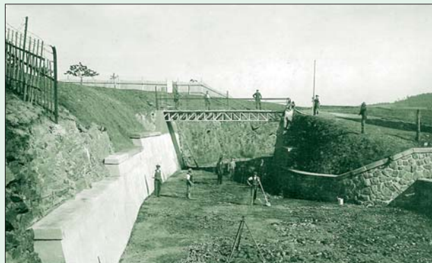
Obr. 41 Spadiště od bezpečnostního přelivu s přemostěním, 1912
