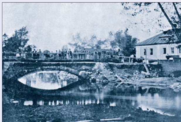
Obr. 25 Silniční most přes Chrudimku v Hlinsku po povodni, 1880
