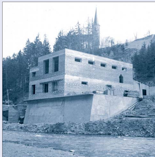
Obr. 86 Rozestavěná budova špičkové vodní elektrárny Křižanovice, 1951
