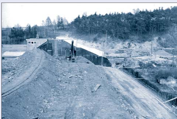
Obr. 83 Staveniště hráze vyrovnávací nádrže Práčov, 1951
