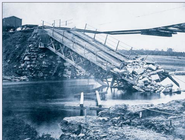
Obr. 24 Stržený železniční most přes Chrudimku ve Stanu u Hlinska, 1880
