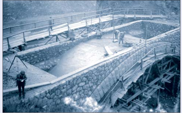
Obr. 64 Klenba přemostění spadiště od bezpečnostního přelivu, 1925
