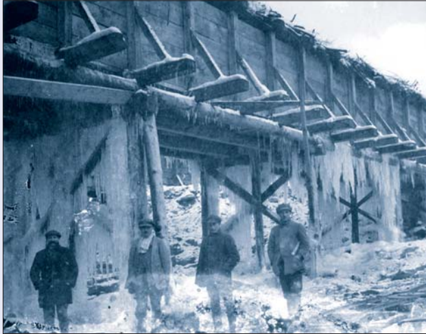
Obr. 63 Jeden ze žlabů na převod vody přes staveniště, 1925
