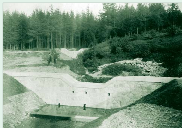
Obr. 93 Přepážky na horním toku Plaňavského potoka, 1910
