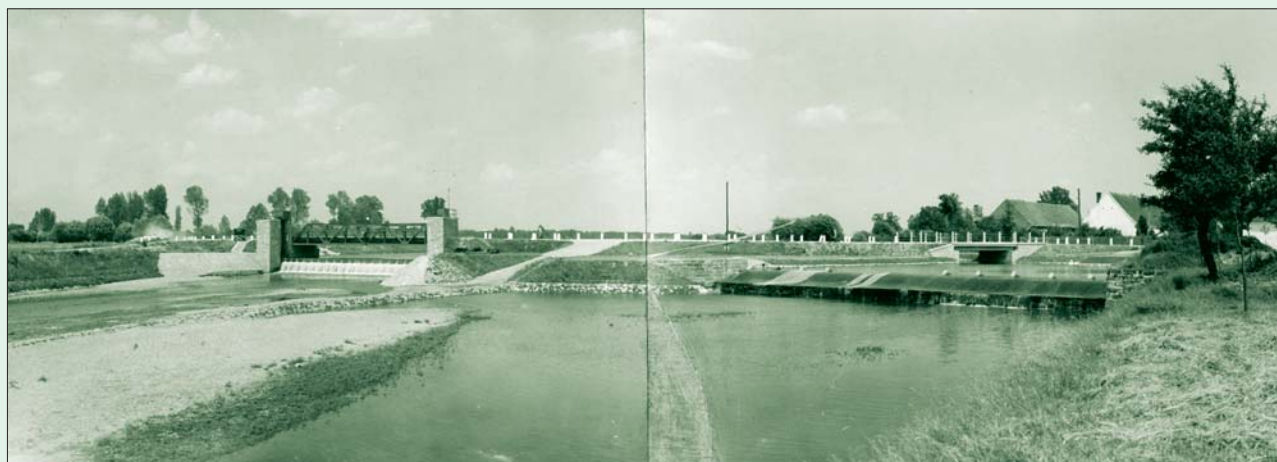
Obr. 95 Nový válcový jez ve Mněticích, vpravo původní koryto Chrudimky s pevným mlýnským jezem, 1937
