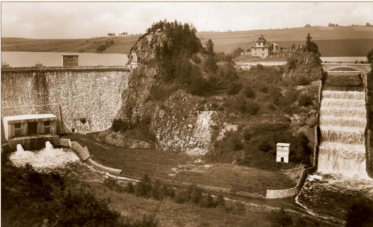
Obr. 87 Celkový pohled na dokončenou přehradu Seč s kaskádou od bezpečnostního přelivu, 1938
