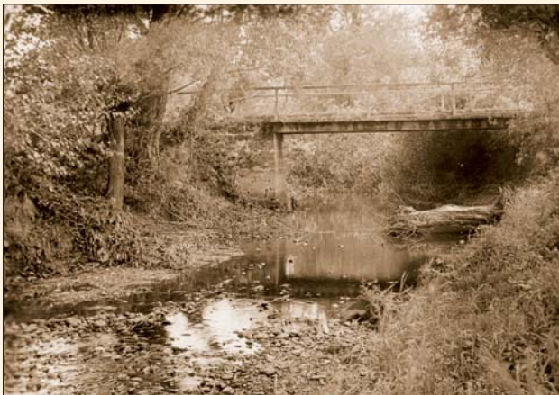
Obr. 34 Chrudimka u Kalousova mostu před úpravou, 1928
