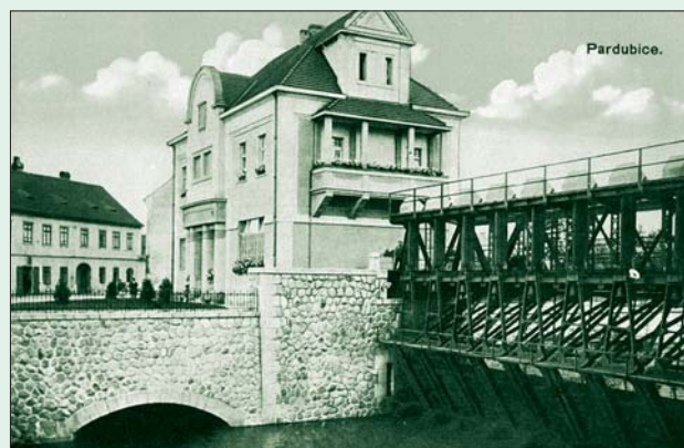
Obr. 92 Záhorského poklopný jez v Pardubicích, 1915
