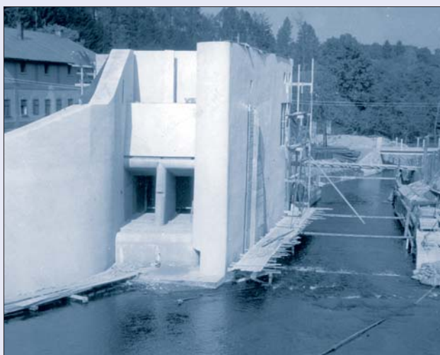
Obr. 85 Rozestavěná budova průběžné vodní elektrárny Práčov, 1951
