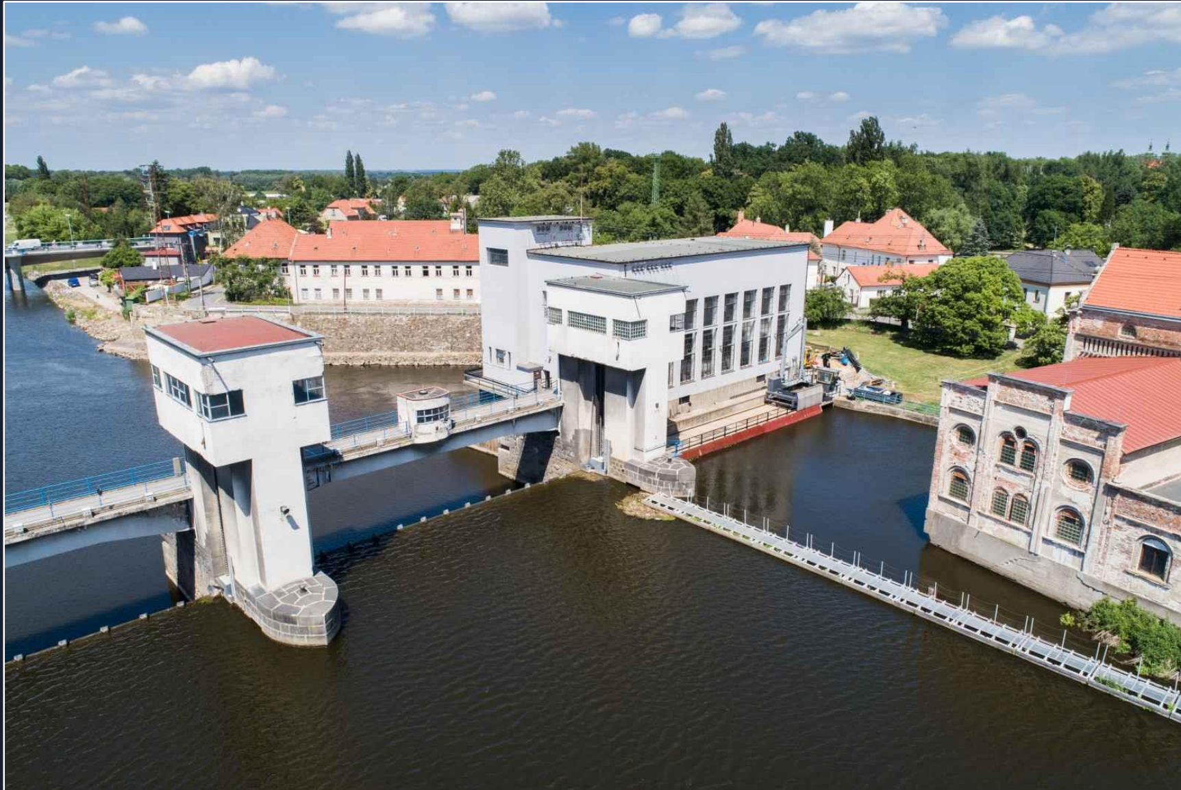
Malá vodní elektrárna těsně přiléhá k pravobřežnímu jezovému pilíři.
