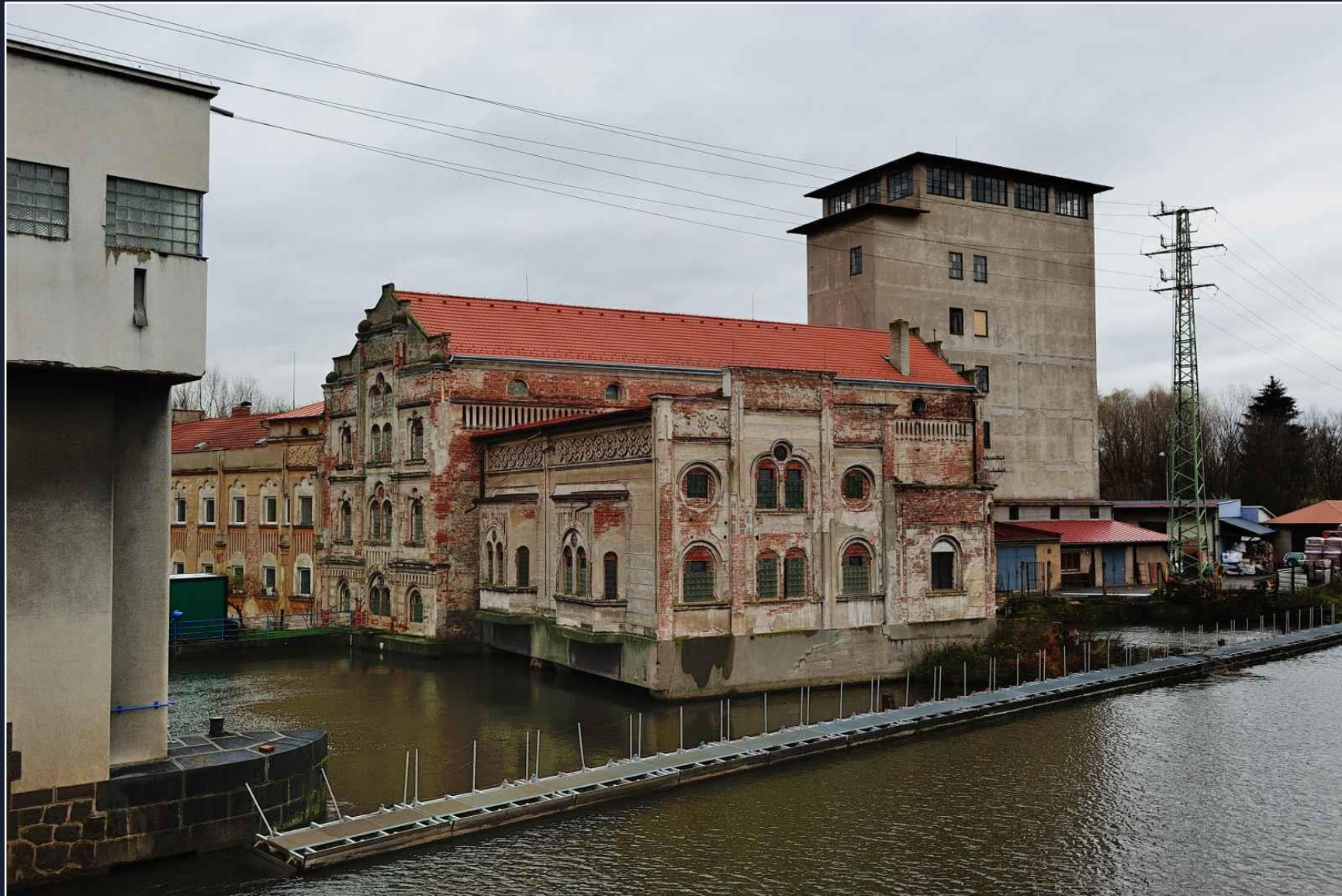
Nátok na vodní elektrárnu je osazen hrubými česlemi s obslužnou lávkou (v pozadí budova Šorelova mlýna).
