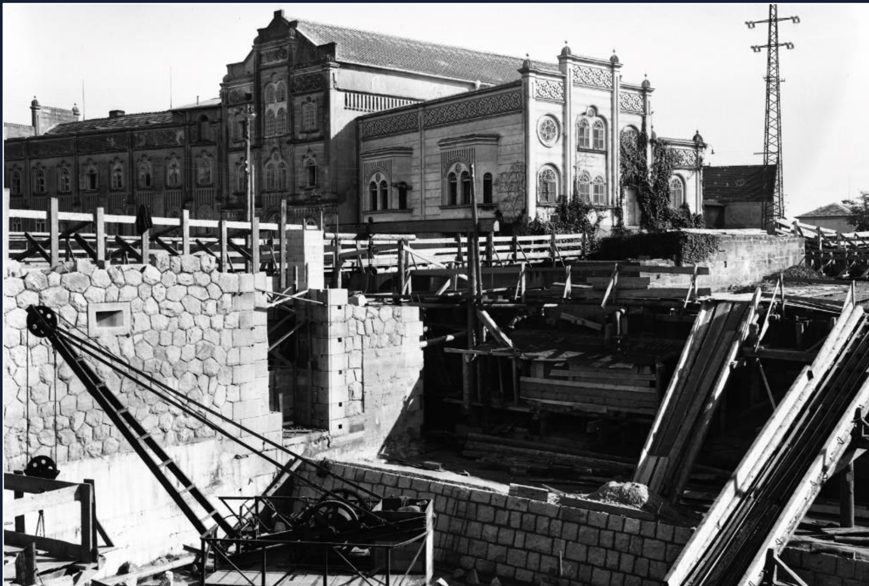
Nový pohyblivý jez byl postaven v letech 1931-34.
