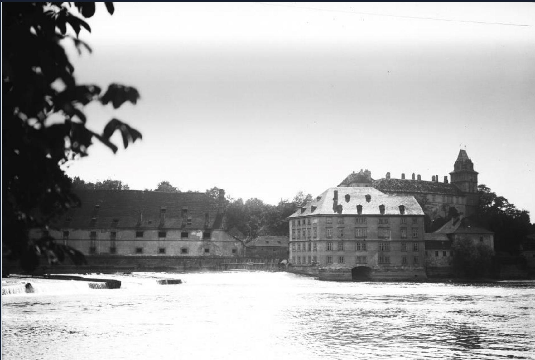
Předchůdcem dnešního jezu byl pevný jez staropražského typu (snímek z roku 1907).
