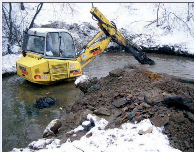
Vítkovský potok, úprava rozdělovacího objektu
