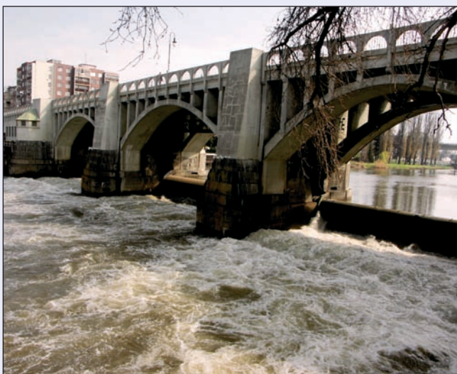
Labe, jez se silničním mostem v Kolíně
