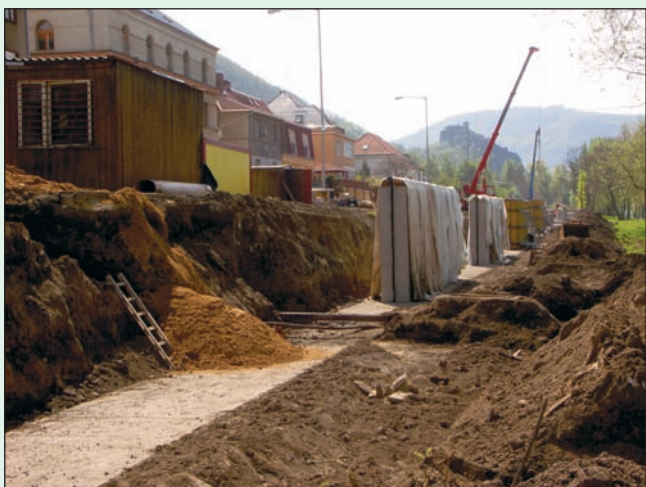
Labe, rozestavěná stavba, Ústí nad Labem - Střekov (2008)
