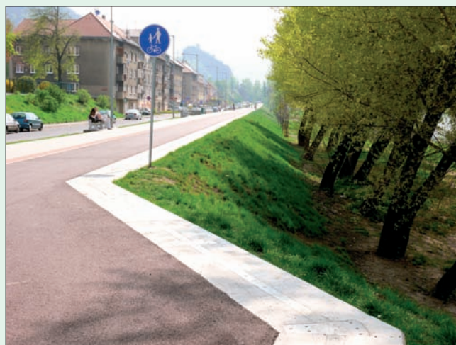
Labe, dokončená stavba, Ústí nad Labem - Střekov (2009)
