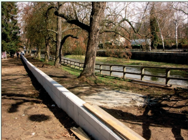
Tichá Orlice, protipovodňové opatření v Chocni
