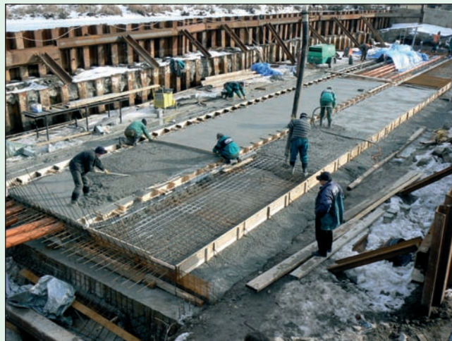
Jizera, rekonstrukce jezu v Turnově
