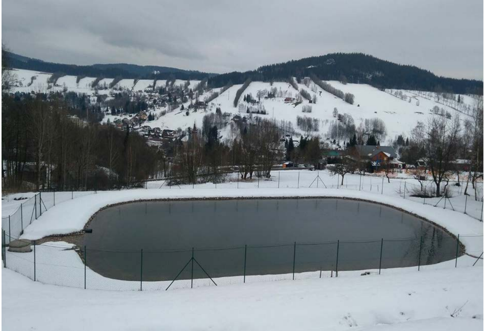
Odběr povrchové vody z retenční nádrže pro areál Pařez v Rokytnici nad Jizerou
